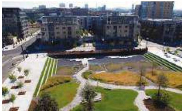
Abb. 9: Grüne Mitte Essen. Ein abgesenkter Platz bietet Schutz vor dem Lärm und Verkehr, lädt aber nicht nur zum erholsamen Aufenthalt ein, sondern entfaltet auch Schwammfunktion und dient bei Starkregenereignissen als Wasserreservoir als Beispiel für multicodierte Grünflächenfunktionen (Foto Frank Vincken. 2016)
