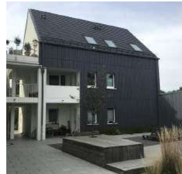
Blick auf L-förmige Gebäude mit Laubengang © Andrea Döring
