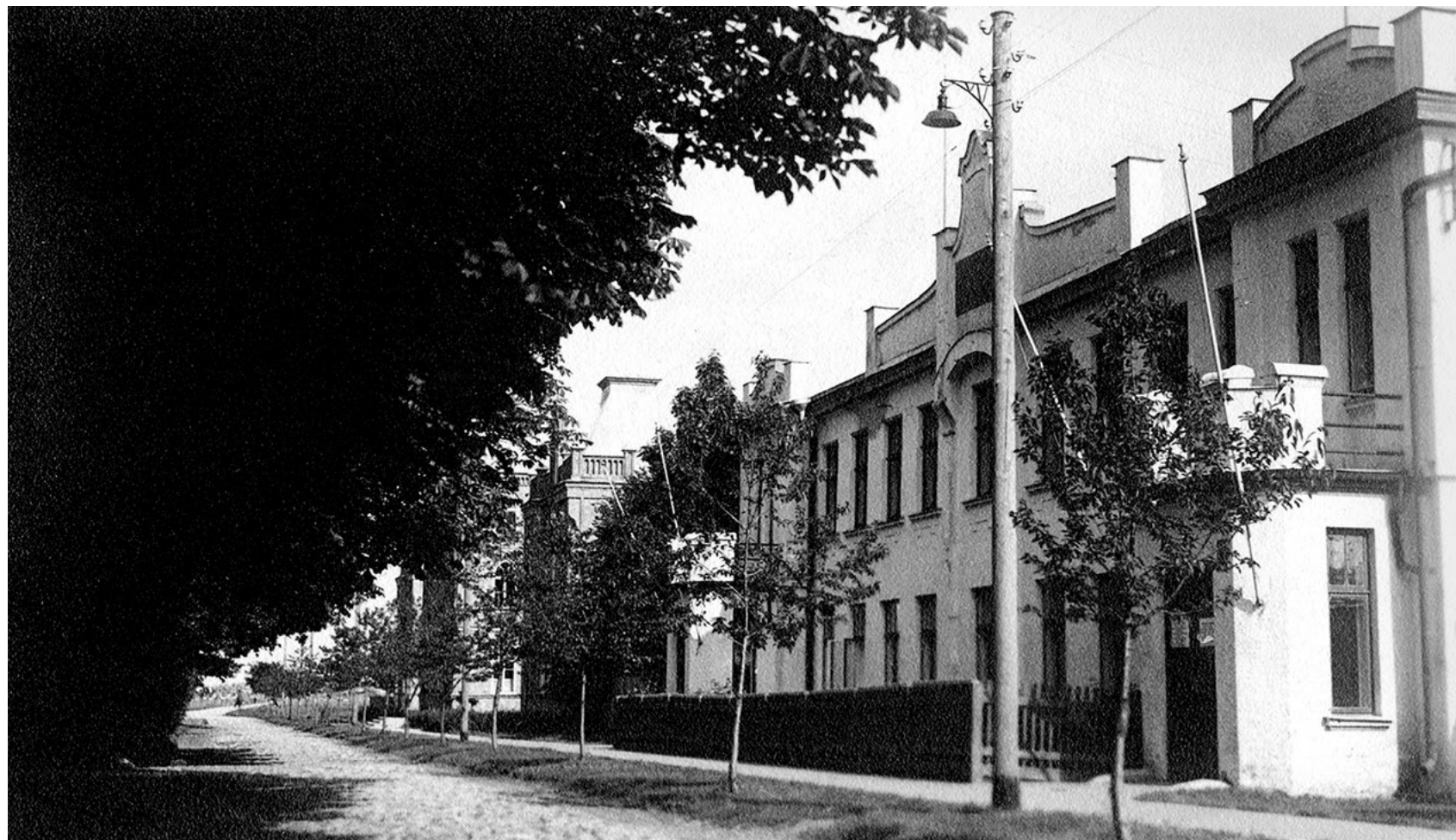
Latvijas Bankas Ventspils nodaļas nams Ventspilī, Kuldīgas (vēlāk – Vadoņa, Padomju, Ļeņina, tagad – Kuldīgas) ielā 3. Celts 1910. gadā kā bankas nams. 1912. gadā tajā atradās Valsts renteja. Toreiz ēkas adrese bija Kuldīgas iela 37. Pirmā pasaules kara vācu okupācijas gados ēkā tika iekārtots cietums, kas tur darbojās vismaz līdz 1919. gadam. Pēc tam celtne atkal izmantota kā bankas ēka, tajā atradās Latvijas Bankas Ventspils nodaļa. No 20. gs. 20.–30. gadiem saglabājušās vairākas pastkartes ar bankas attēlu. Ventspils muzejs, VVM_27981_594. Fotogrāfs – nezināms
