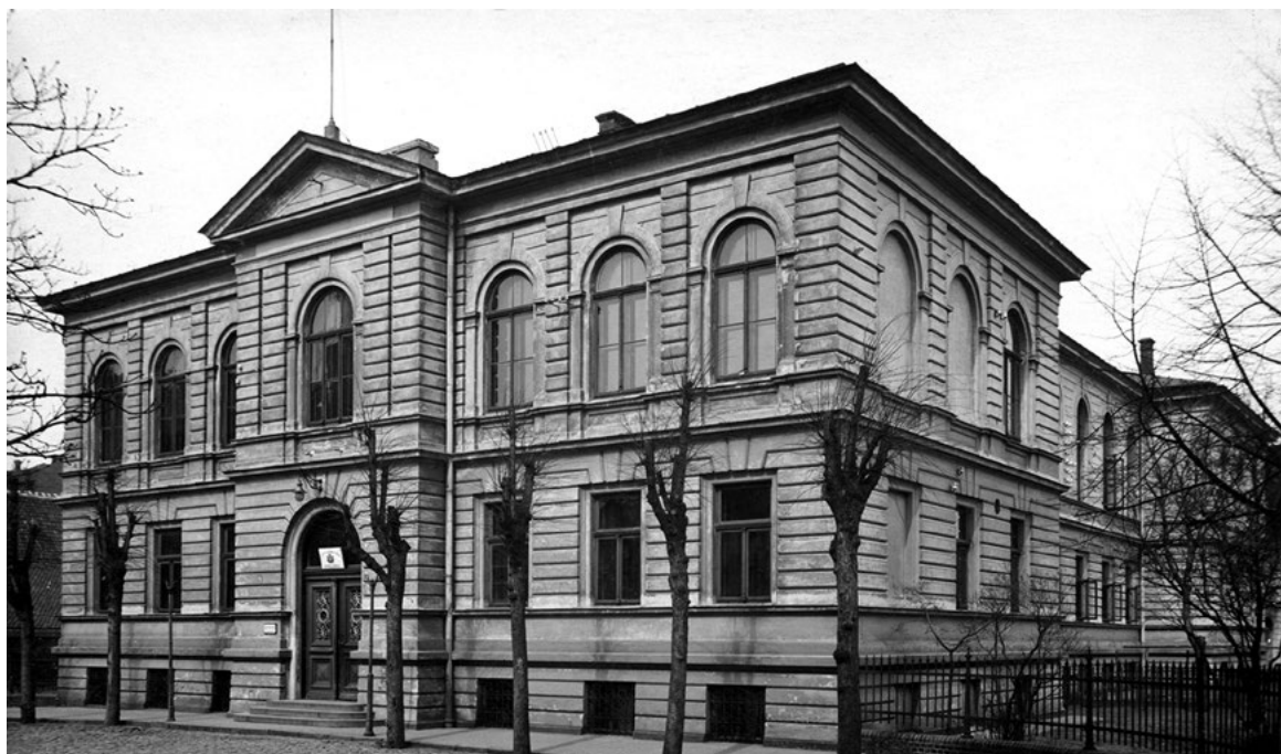
Latvijas Bankas Liepājas nodaļas ēka Liepājā, Teātra ielā 3. 20. gs. 30. gadi. Latvijas Nacionālais vēstures muzejs, IN 8087. Fotografārs – nezināms
