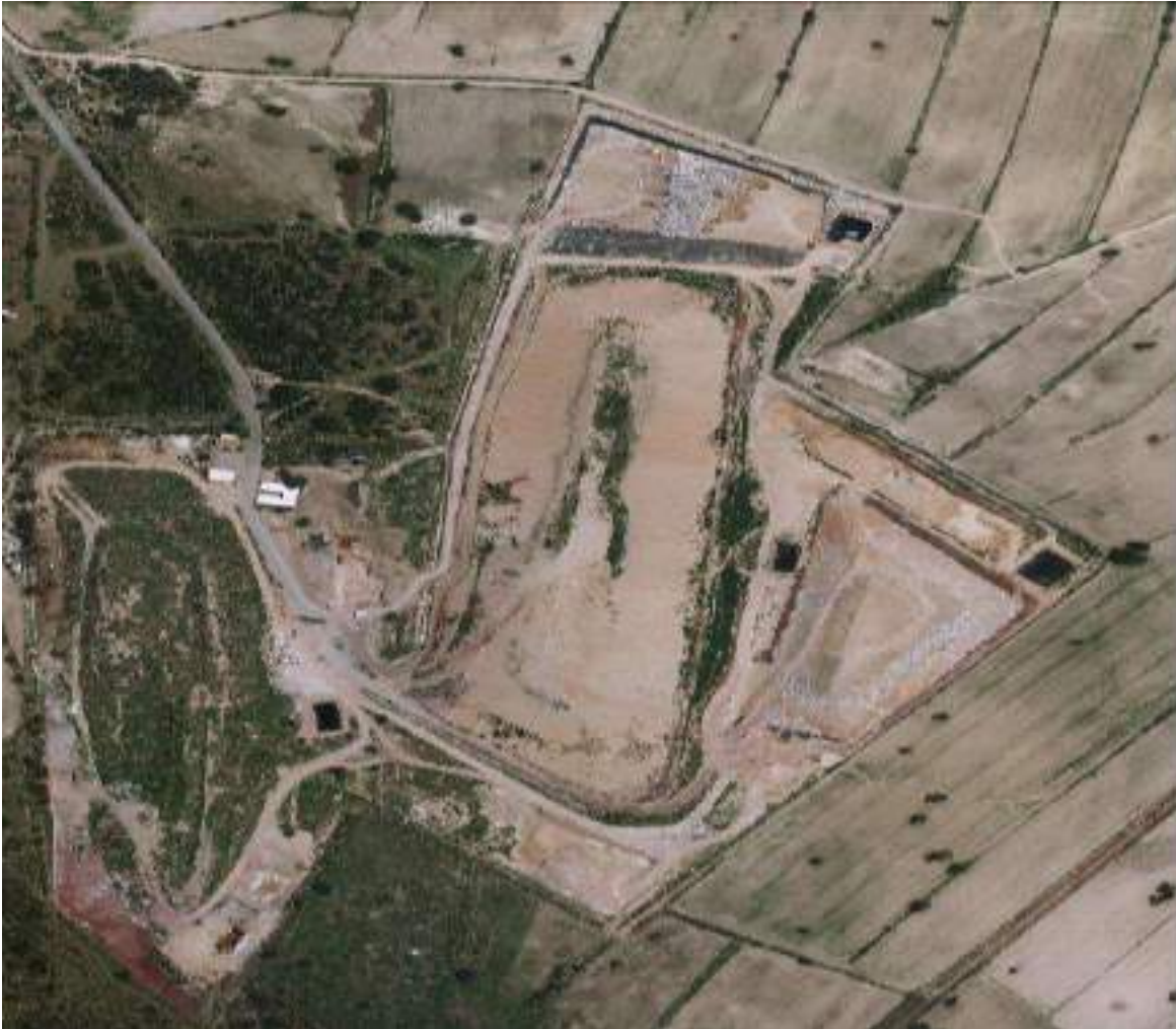
Figura 245. Relleno sanitario el Huixmí ubicado a 25 km de la ciudad de Pachuca de Soto, Hidalgo.
