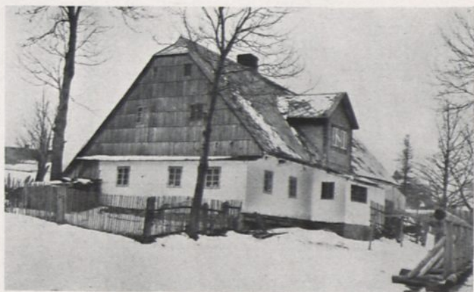
Abb. 4: Die ausgebaute Heuluke an einem Hause in Spornhau
