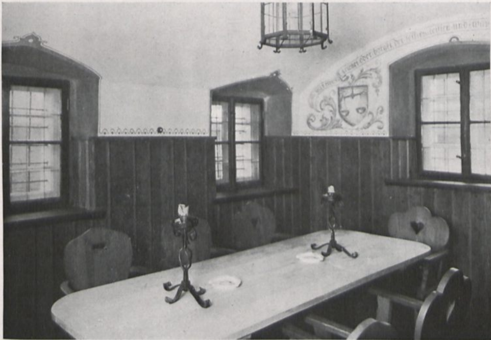
Alter Gerichtskreisam Liebichau. Innenansichten nach dem Ausbau
