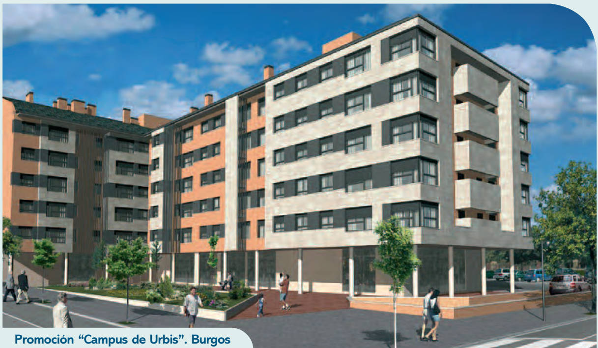
Edificio Sanz Pastor. Burgos
