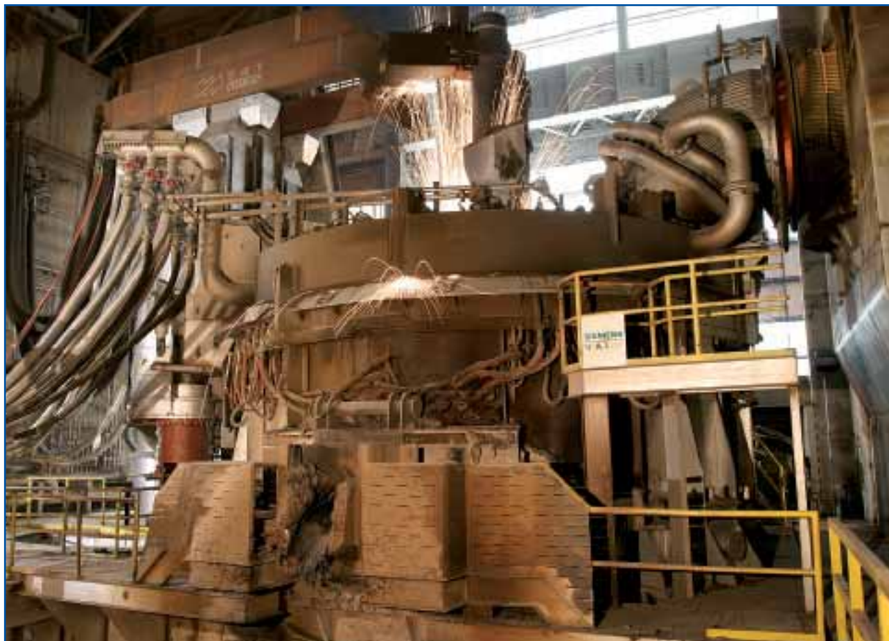
Horno eléctrico nº 2 NAS
