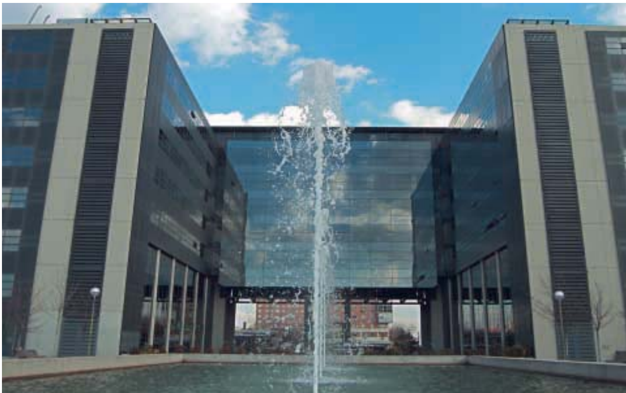
Edificio Castellana 257. Madrid
