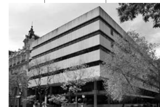
Edificio Alfonso XIII Madrid
