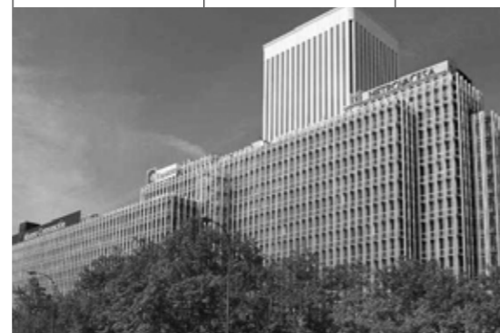
Edificio Castellana 278.280 Madrid
