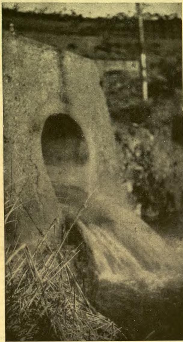
Evacuació d'aigües residuals de Potasses de Sària
