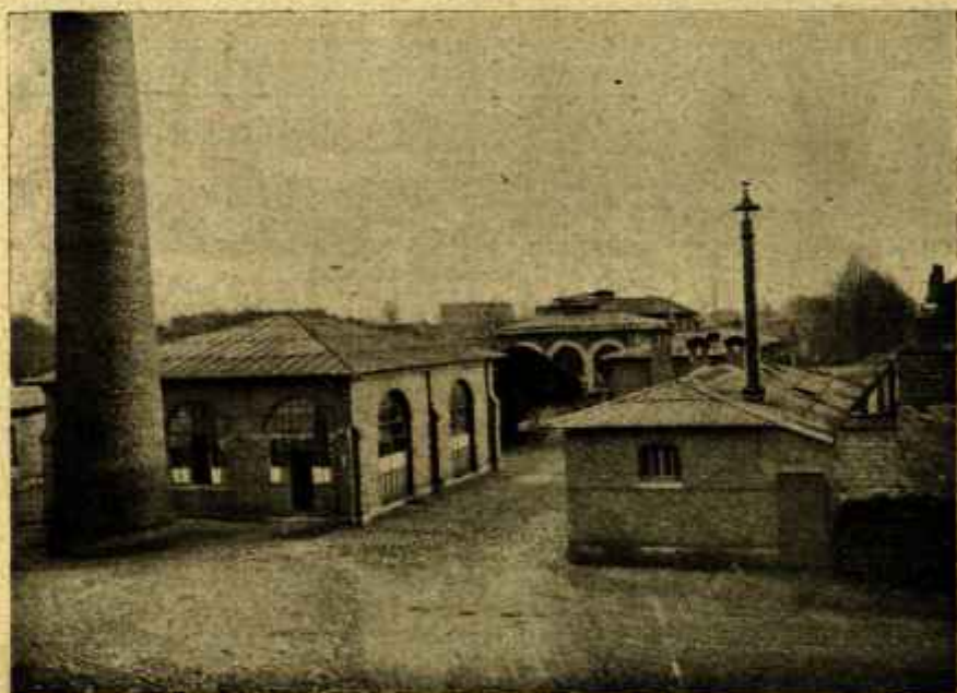
Fábrica de calefacción.—Pabellón de enfermedades contagiosas.
