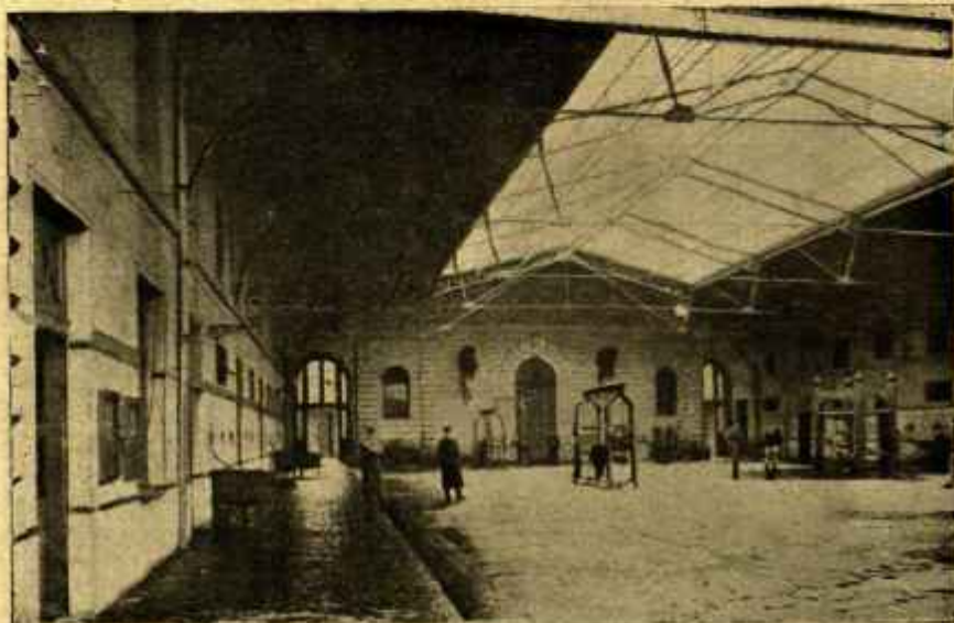
Vista interior del hall de clínica.
