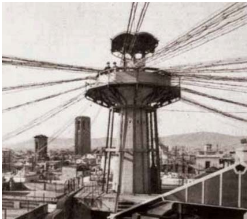
Fig. 35. Tendido de cables de telecomunicación sobre Barcelona.
