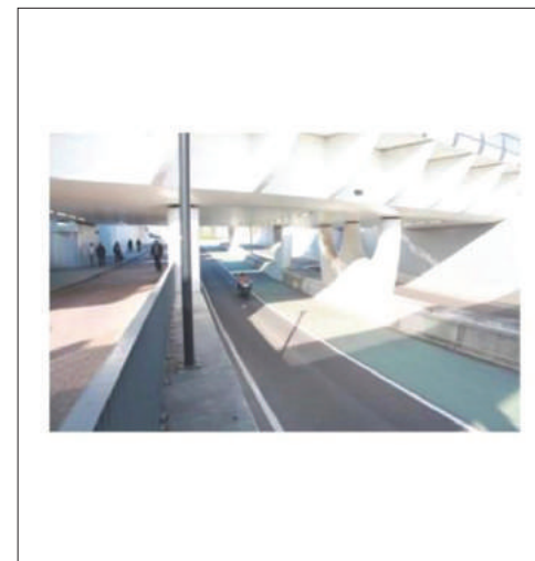
Meester Bouhuijstunnel upgraden
