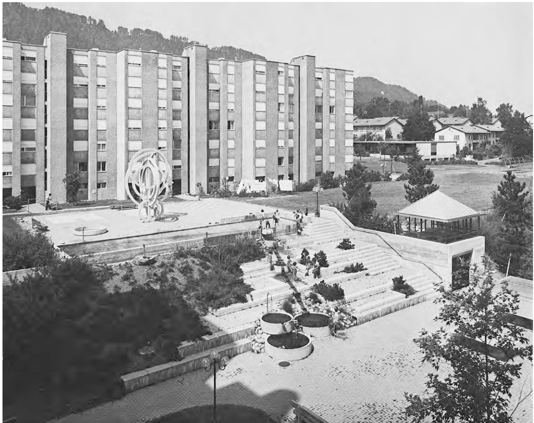
Utohof: Blick in die Anlage um 1975 [Hochbauamt der Stadt Zürich (1978)].
