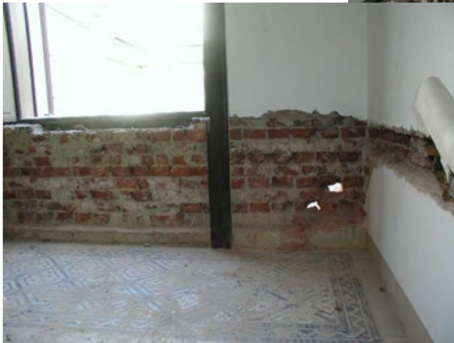
Und zum Abschluss stemmt die Haustechnik in die hoch belasteten Stiegenhauswände tiefe Schlitze ohne Rücksprache mit dem Statiker....
