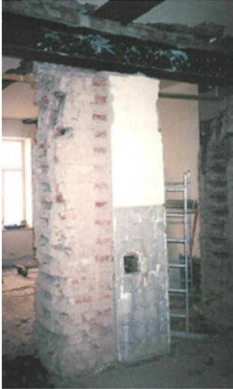
Erkennbar ist eine ehemalige Zwischenwand, die in die Reste des Pfeilers verschmätzt ist. Der neue Unterzug ist ein Stahlträger, der die Lasten der Mittelwand sowie die Deckenlasten samt Zwischenwänden übernehmen wird.
