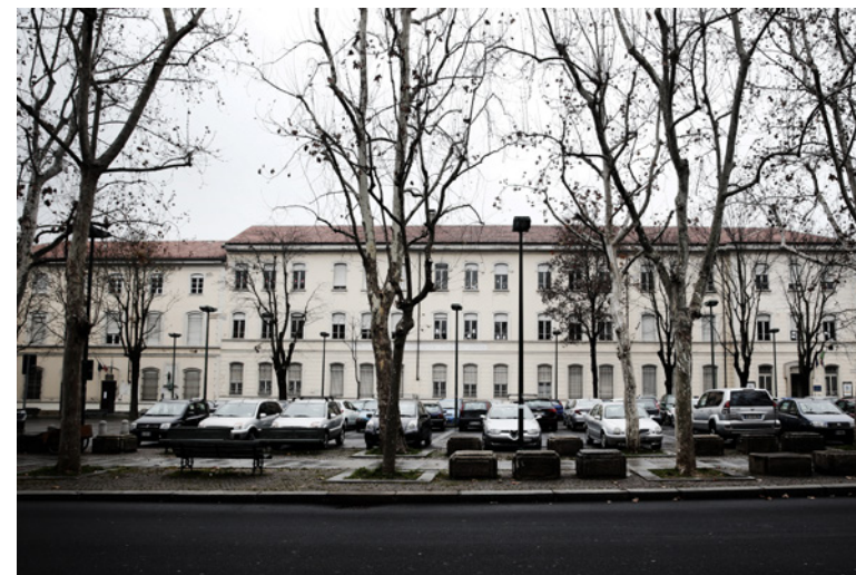
Fig. 18 - La facciata della Manifattura Tabacchi di Torino. Foto Vittorio Zunino Celotto - Getty Images per Urban Center Metropolitan Torino.
