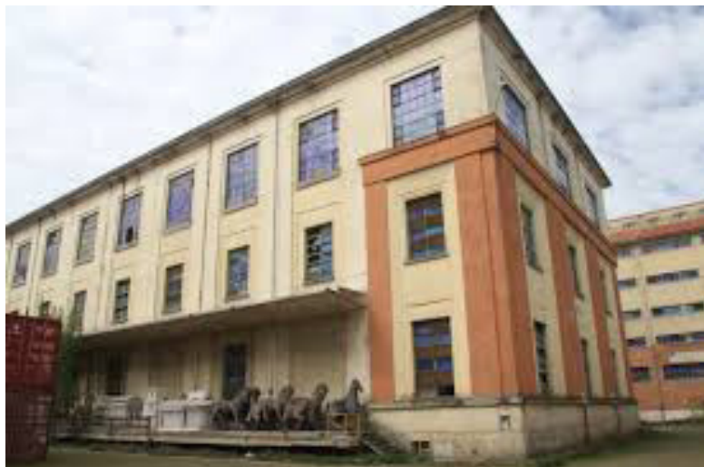
Fig. 8 - Edifici in abbandono.
