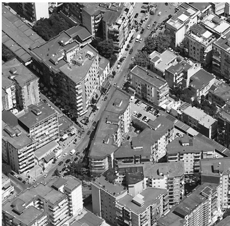
Fig. 5 - Casoria, paesaggi urbani: la strada-mercato e la corona di cemento.
