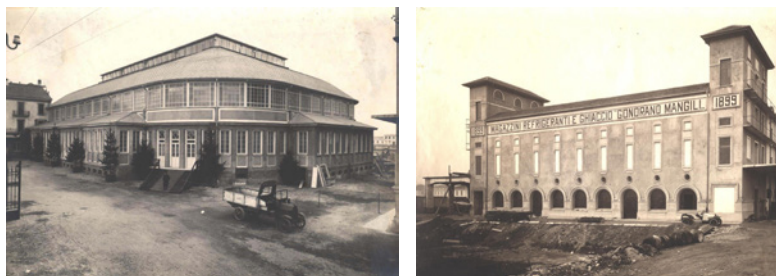
Fig. 7 - Palazzo del Ghiaccio e Magazzini Refrigeranti;
