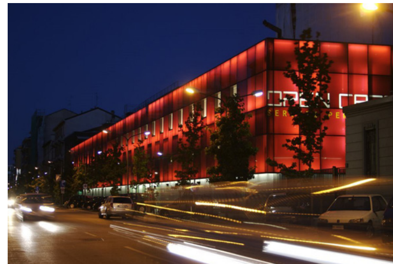
Fig. 11 - Frigoriferi Milanesi, Via Piranesi, Milano
