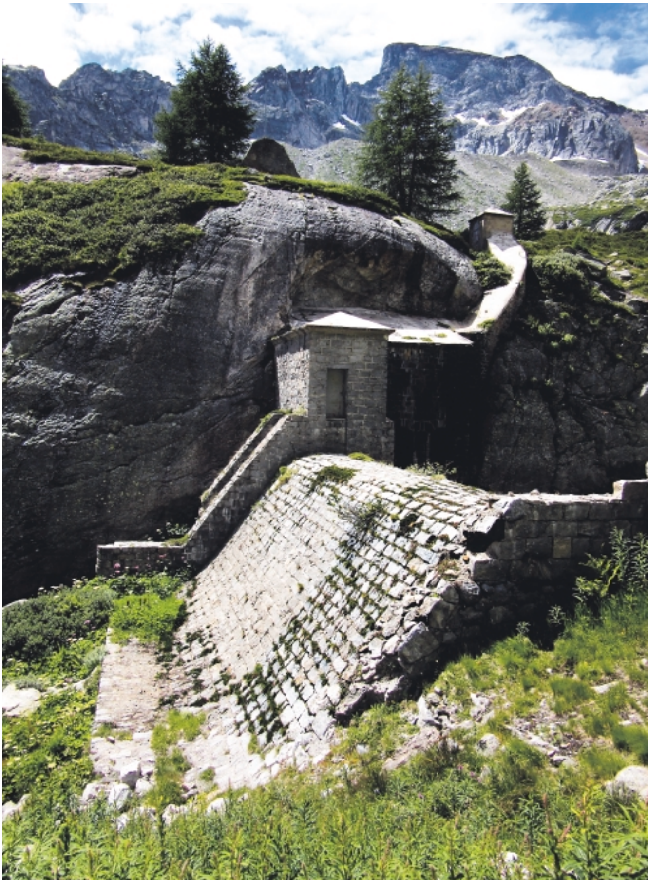
Traversa "Dighetta" sul rio Vannino che alimentava l'invaso detto "Polmone", Val Formazza (VB). Foto di Enrico Rondena - 1° Concorso Fotografico ITCOLD 2018.
