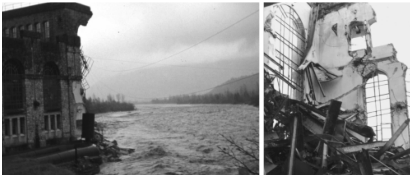
Figura 16 - Centrale di Pedesalto erosa delle acque del Cismòn durante l'evento del 3-4 novembre 1966.
