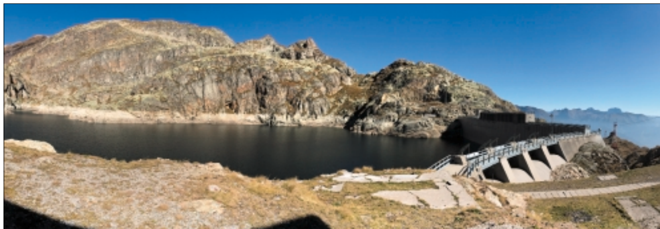
Figura 9 - Diga di Lago Nero – ristrutturazione completa.
