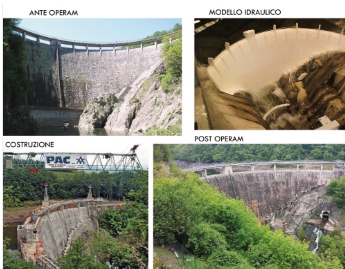
Figura 7 - Diga di Valla – aumento della sezione di efflusso dello sfioratore di superficie.
