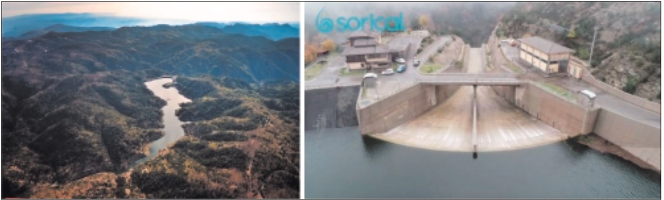
Figura 11: Diga del Menta (RC) – vista del lago artificiale e dello scarico di superficie allo sfioro.
