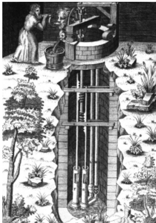
Figura 4 - Sollevamento con pompe a stantuffo.
