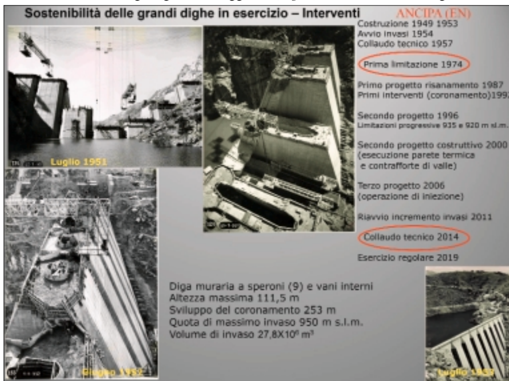
Figura 7 - Diga Ancipa Caratteristiche dimensionali e tempistica intervento.
