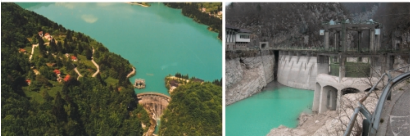
Figura 8 - Diga di Barcis – realizzazione di un nuovo scarico di superficie.
