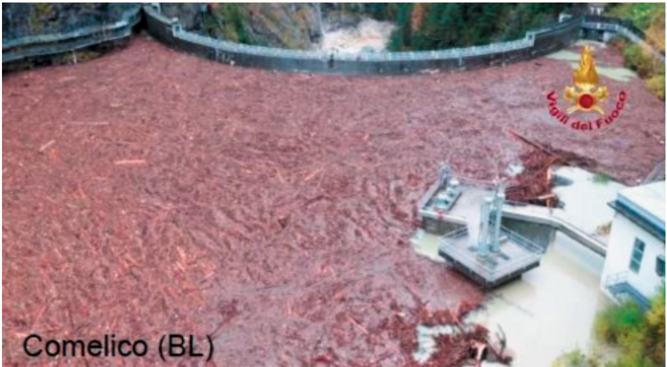
Figura 5 - Immagine del serbatoio di Comelico durante la tempesta Vaia di Ottobre 2018.
