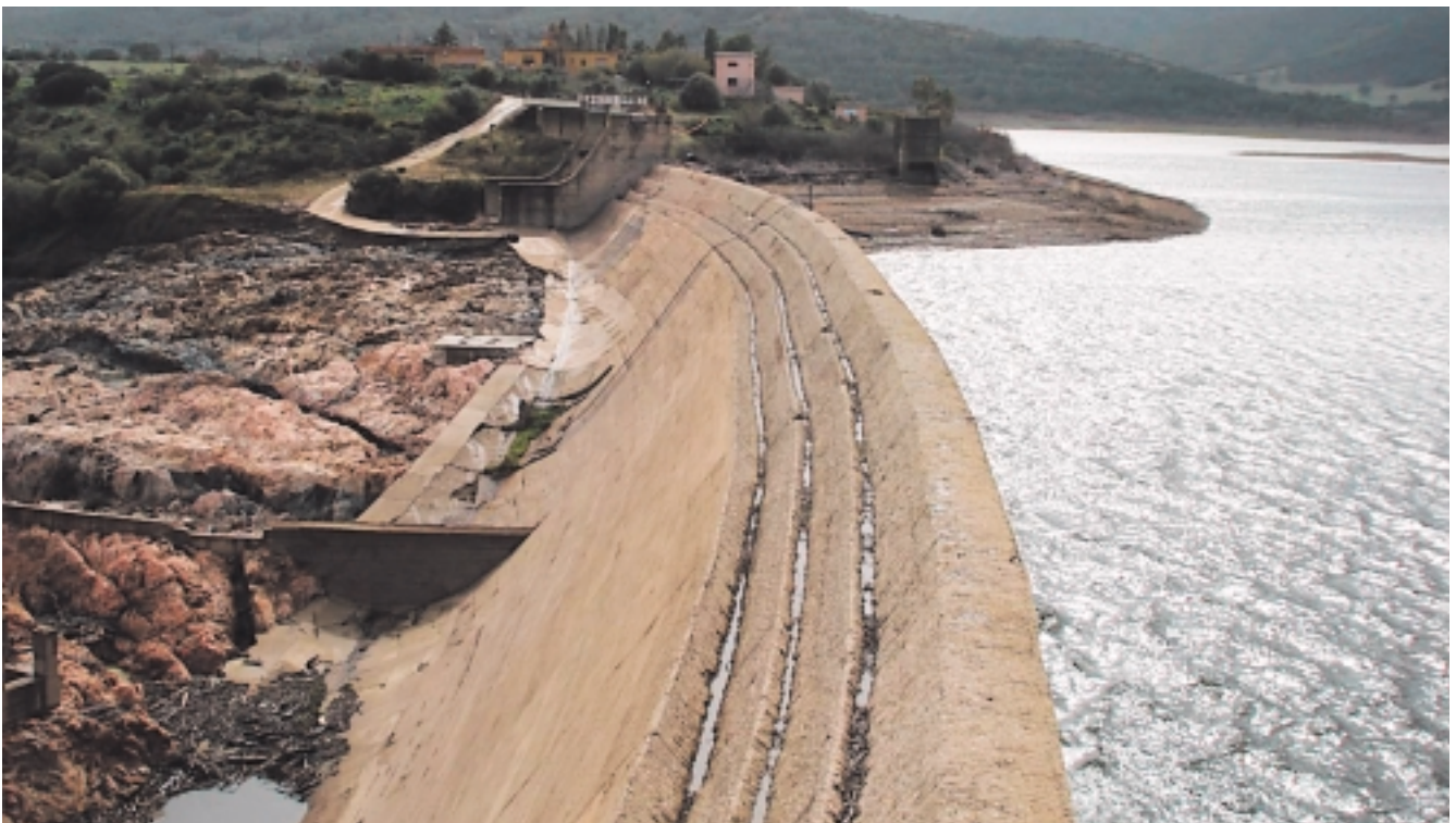
Figura 10 - Configurazione della diga in occasione del verificarsi del ciclone Cleopatra (11 novembre 2013), dovuta ai lavori preparatori al soprizzo del coronamento.
