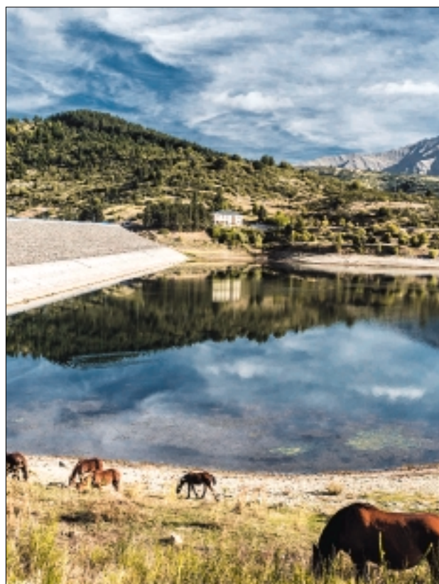
In copertina: Diga di Poggio Cancelli, Lago di Campotosto (AQ). Foto di Egzon Kodrali. 1° Concorso Fotografico ITCOLD 2018.
