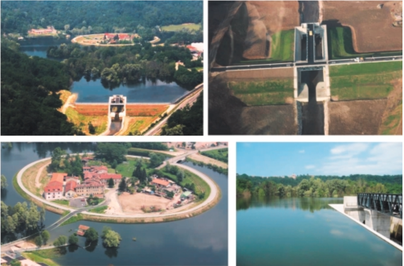
Figura 10 - Diga di Olona (VA) e Mulini di Ponte Gurone.
