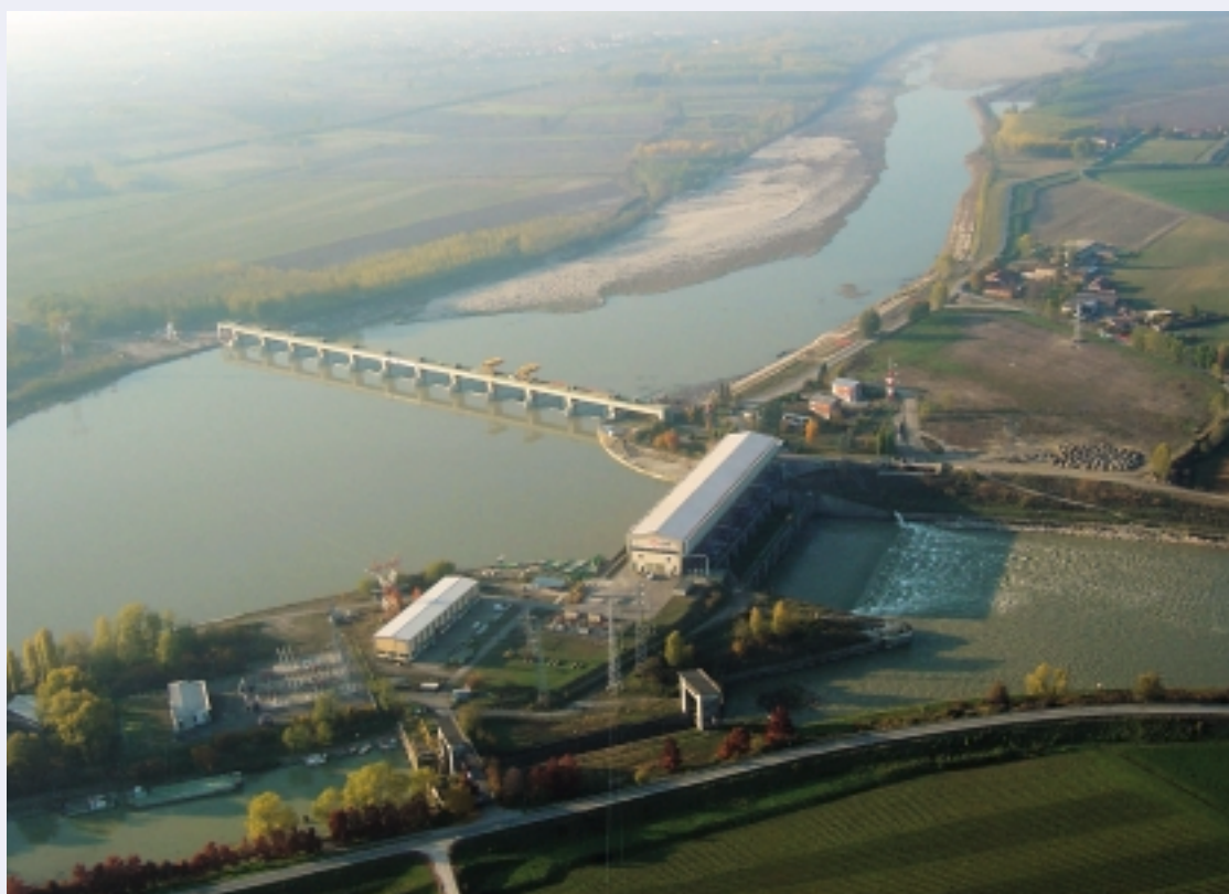
Veduta aerea dell'impianto Isola Serafini sul Fiume Po, (Oldani G. et al., L'Acqua, 5-2008).
