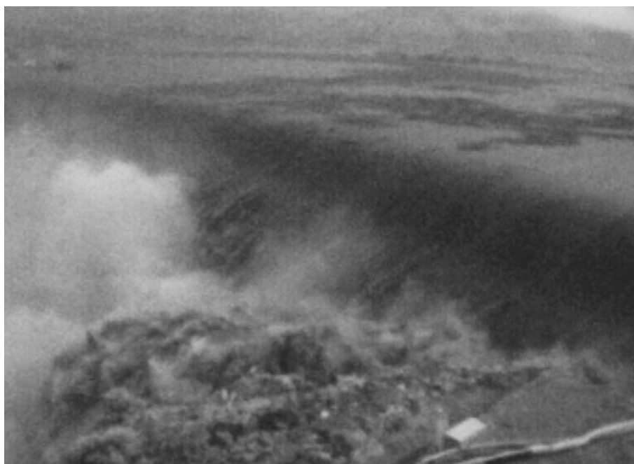
Figura 11 - Sormonto del coronamento della diga di Maccheronis da parte della piena del rio Posada conseguente al ciclone Cleopatra (18 novembre 2013).
