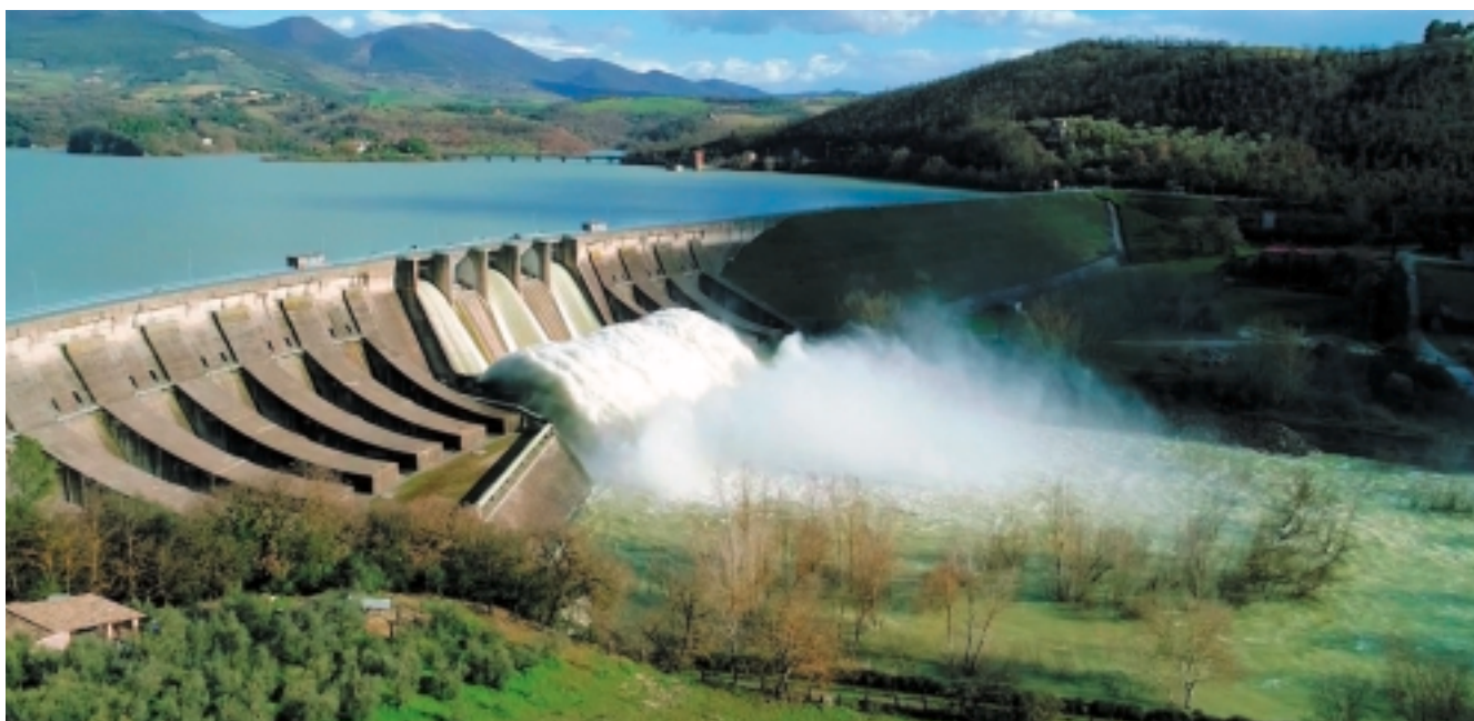
Figura 8 - Svuotamento della diga di Corbara mediante l'apertura delle paratoie poste a presidio dello scarico di superficie.
