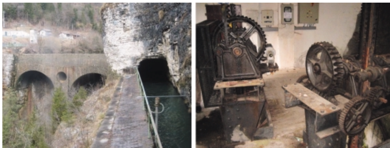
Figura 18 - Parte alta della diga e galleria di presa con sfioro di troppo pieno a monte dell'edificio partitore e, a destra, interno dell'edificio partitore in testa al canale derivatore.
