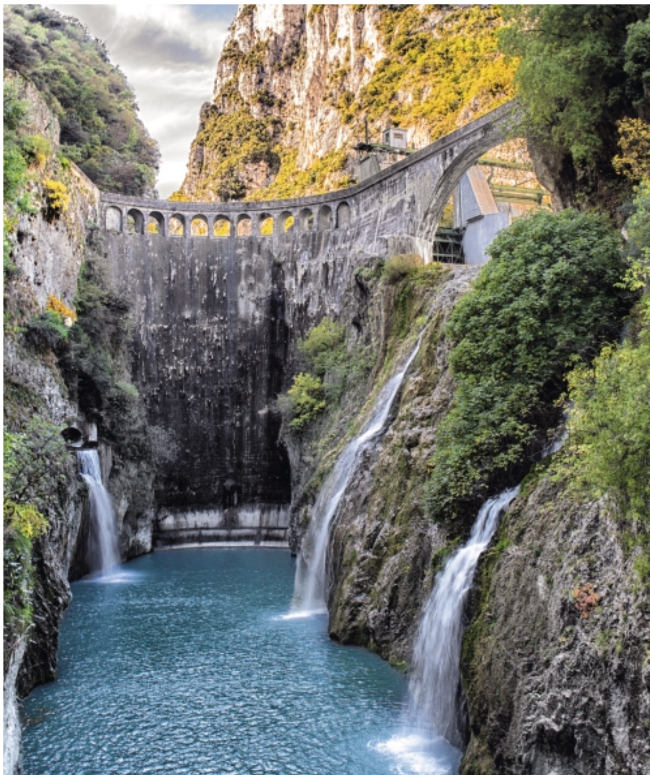
Figura 1 - Diga del Furlo sul Fiume Candigliano (PU). Foto di Egzon Kodrali. 1° Premio del Concorso Fotografico ITCOLD 2018.
