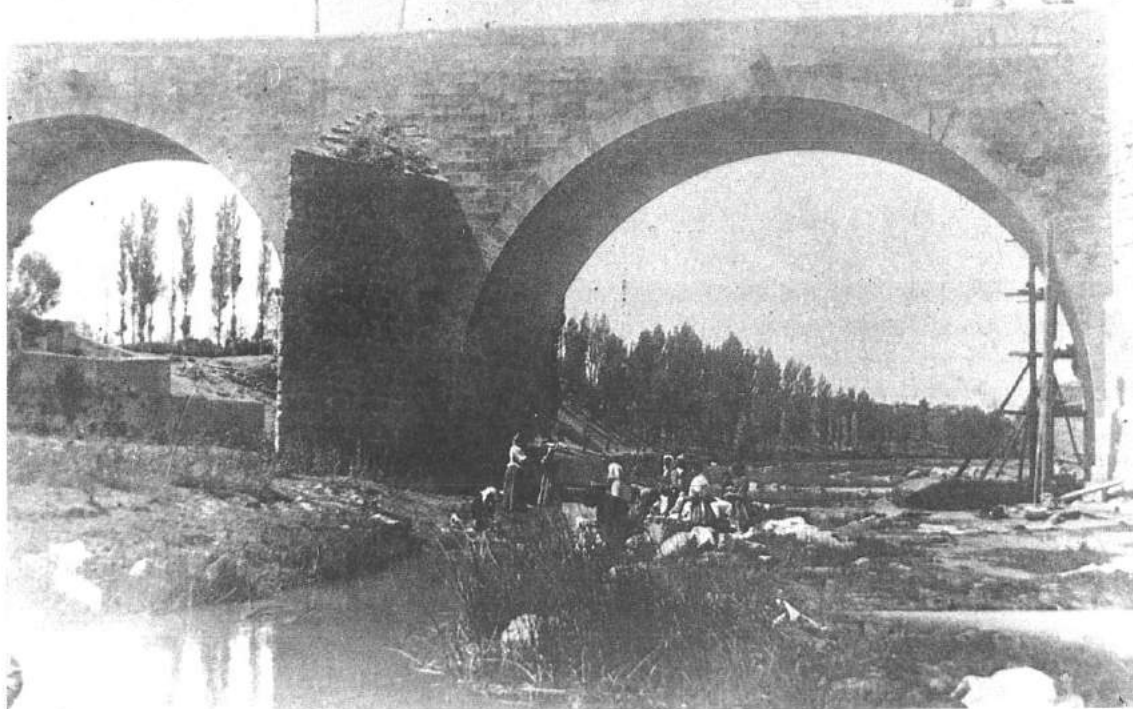
Puente sobre el Duero con andamio de madera. 1886
