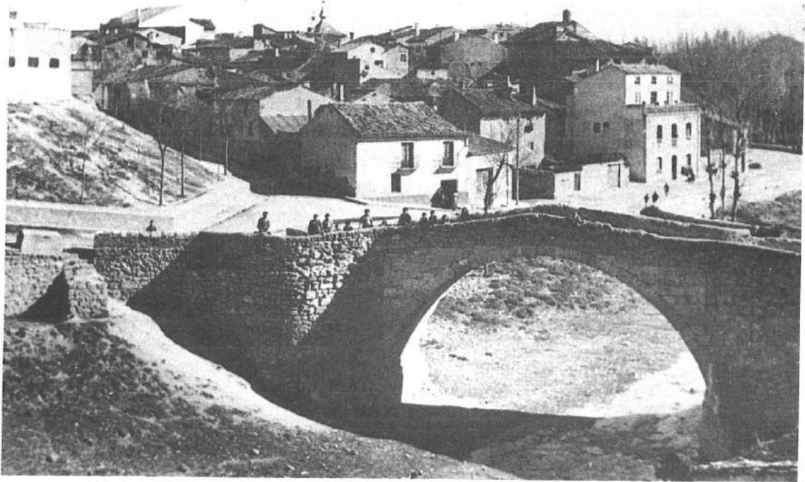
Puente de las Tenerías
