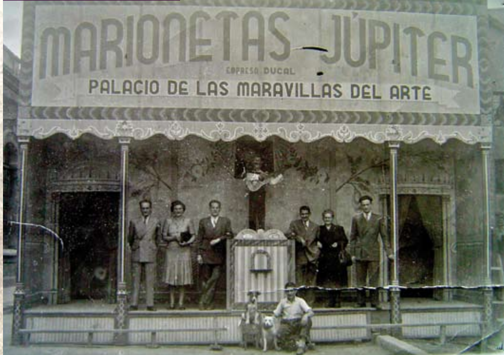
Instalaciones del Teatro Júpiter
