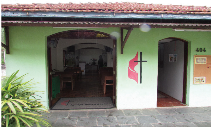
Figura 2 – Fachada da Igreja Metodista em Ribeirão Pires, SP
