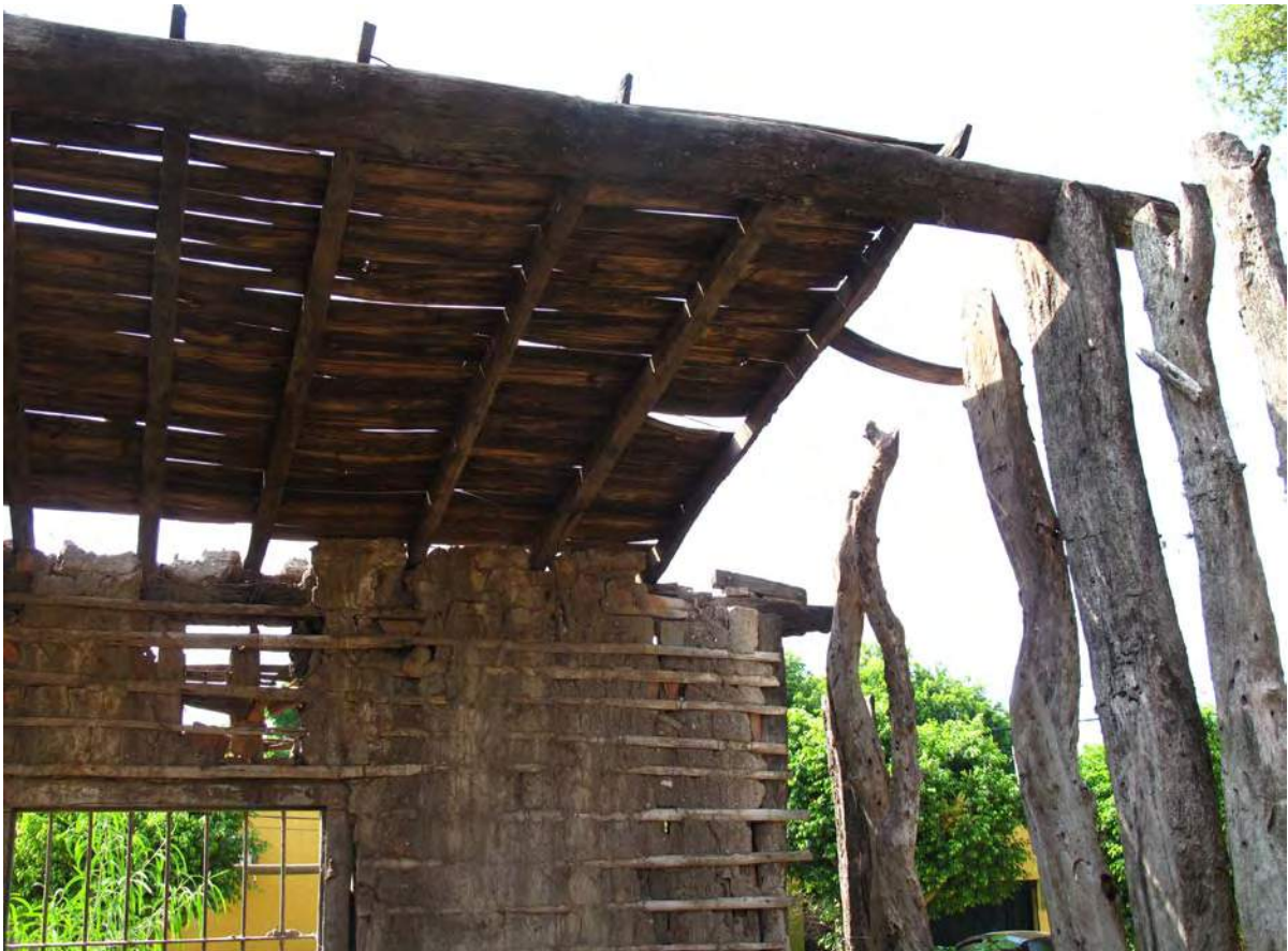
Figura 18. Horcones sujetando la cubierta y listones rellenos de barro (Procedencia gráfica: Díaz, I.).
