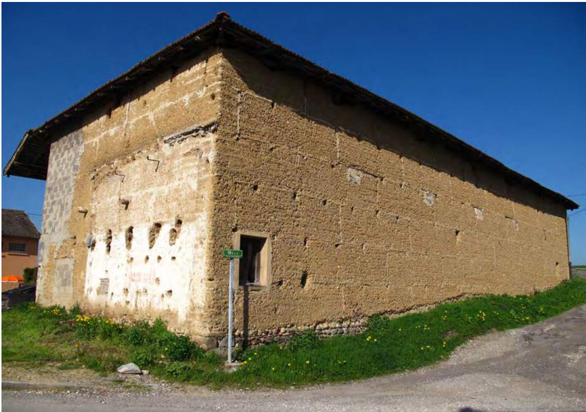
Figura I.1. Vivienda en tapial con inadecuadas reparaciones. (Procedencia gráfica: Díaz, I.).
