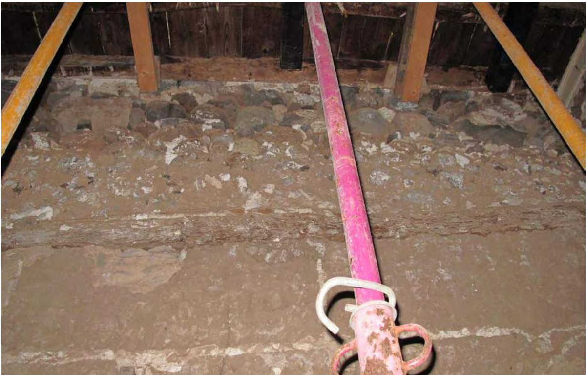
Figura VII.9. Mampostería acordada efectuada con piedras gruesas de playa y mortero de barro sobre el durmiente. (Procedencia gráfica: Díaz, I.).
