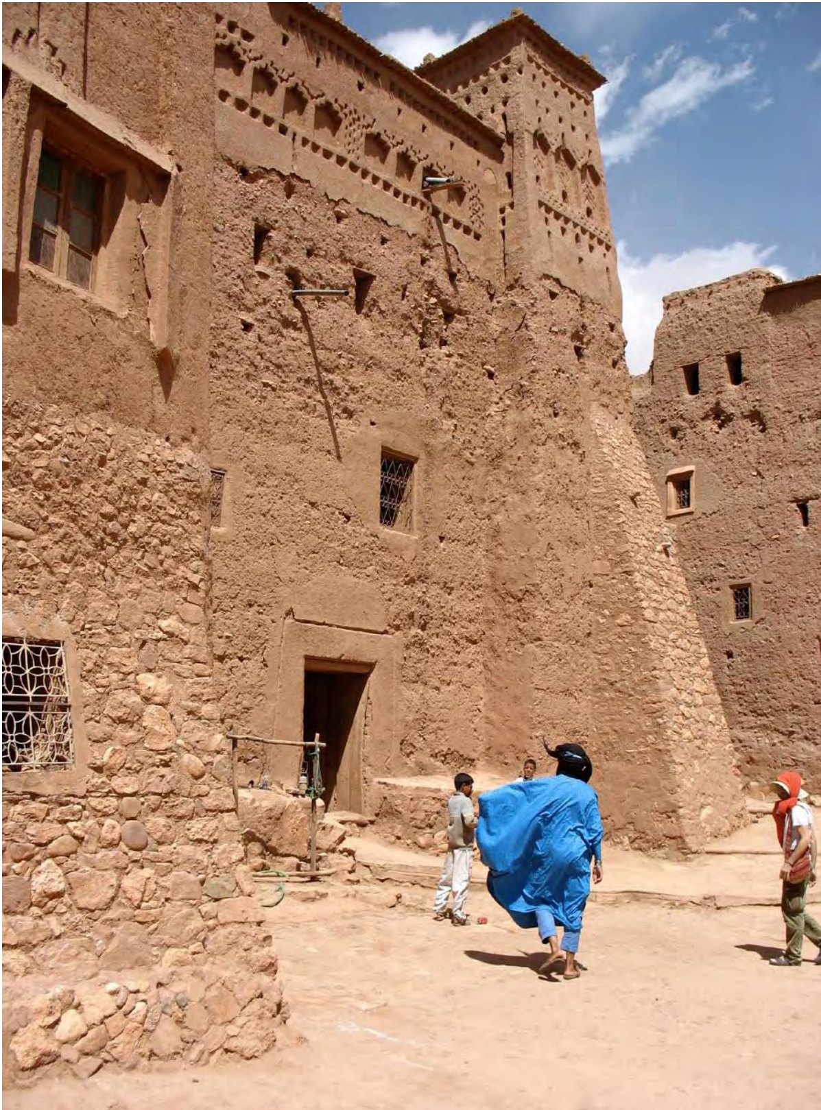
Figura 9. Contrafuertes de piedra, base y cuerpo constructivo en tapial y zona alta decorada con adobes y revocada (Procedencia gráfica: Real, P.).
