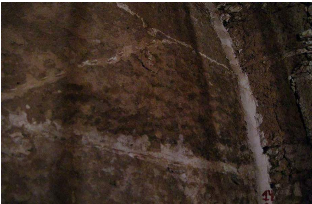
Figura VII.17. Cajón sobre el que se aplicó el trabajo de consolidación, situado en la esquina derecha de la segunda hilada. (Procedencia gráfica: Díaz, I).
