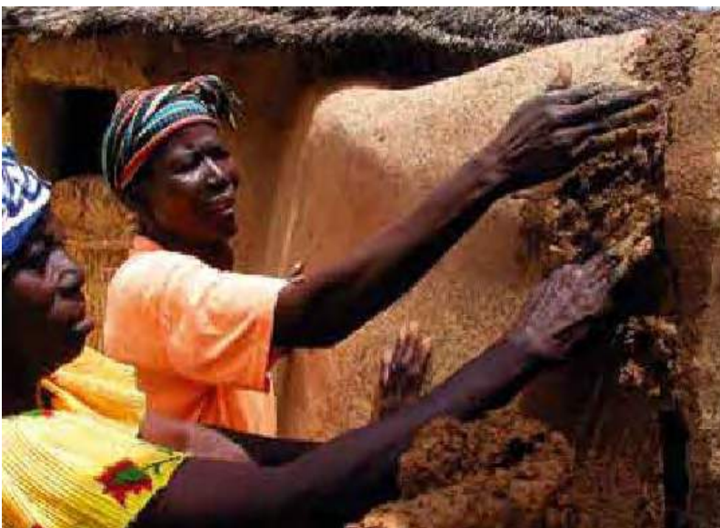
Figura III.7. Trabajos de reparación y reposición de embarrado efectuados por las mujeres de la comunidad. (Procedencia gráfica: Joffroy, T.).
