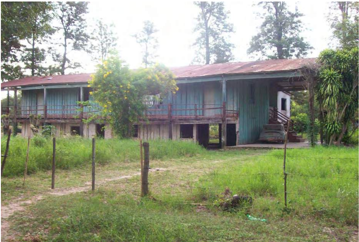
Figura 0.5. Vivienda popular situada en la localidad chaqueña de Vedia, realizada bajo la técnica constructiva del enchorizado. (Procedencia gráfica: López, N.).
