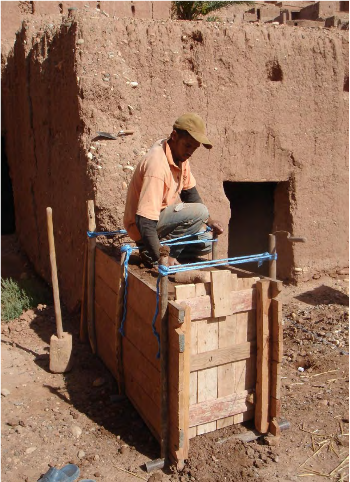
Figura 8. Proceso de elaboración de tapiales (Procedencia gráfica: Alonso, I.).
