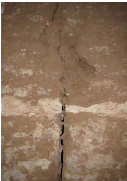
Figuras VII.14 y VII.15. Vista general y detalle de la grieta. (Procedencia gráfica: Díaz, I.).
