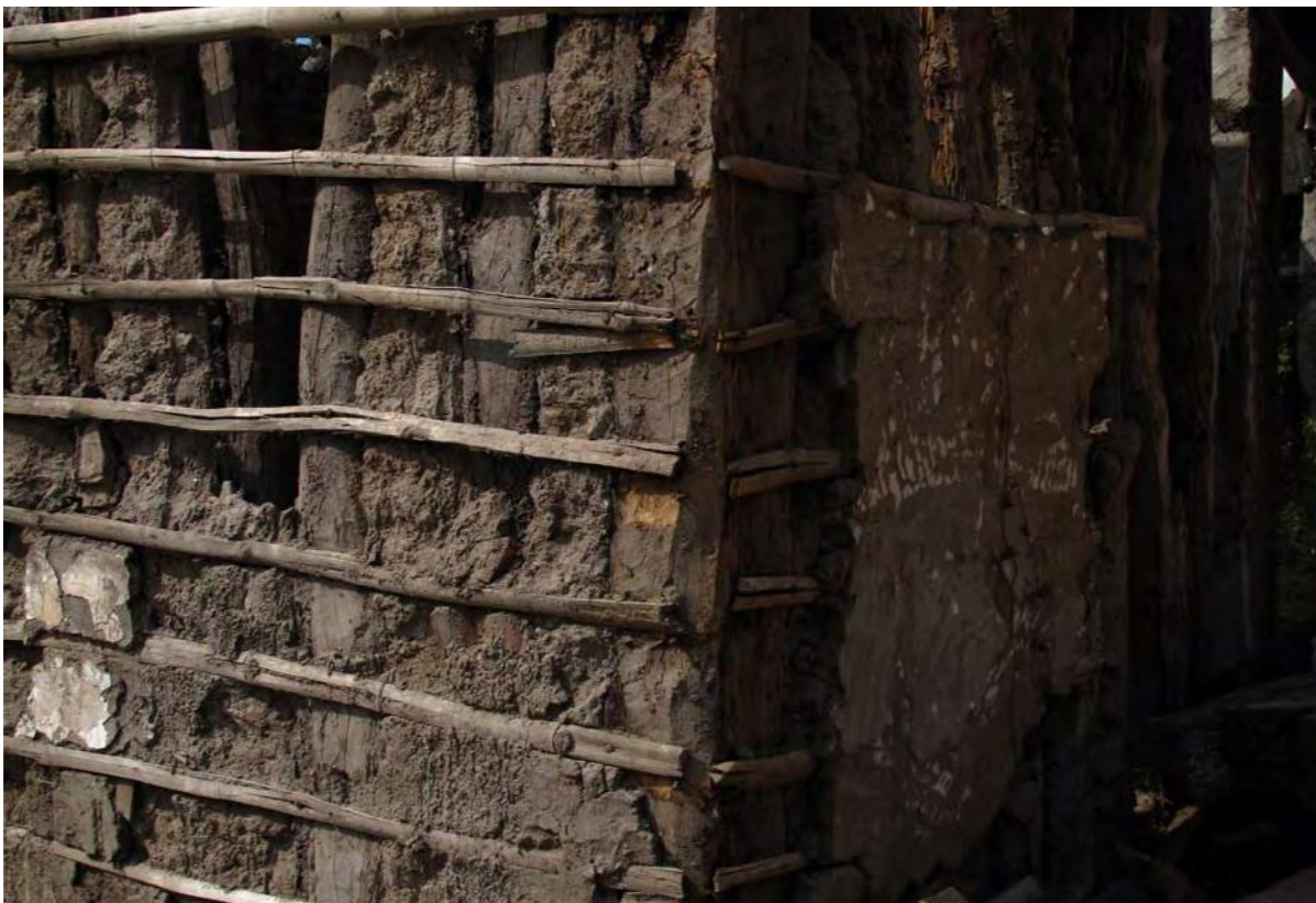
Figura 17. Horcones sobre los que se apoya la estructura horizontal de esta vivienda, rellena de barro y fibras vegetales en la técnica constructiva del estanco (Procedencia gráfica: Díaz, I.).
