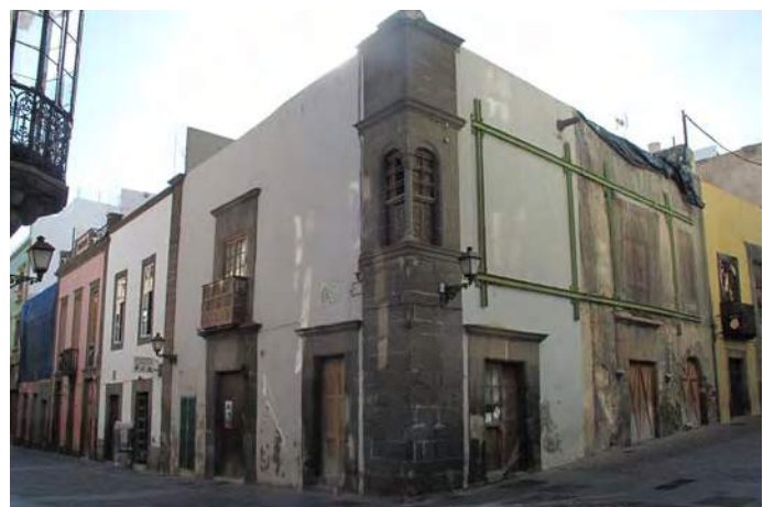
Figuras VII.1 y VII.2. Diferentes vistas de la vivienda a lo largo de los años, donde se aprecia el progresivo deterioro de la misma. (Procedencia gráfica: Archivo fotográfico de la Fedac y Díaz, I.).
