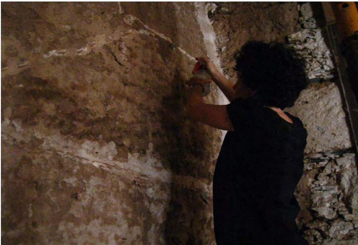
Figura VII.18. Proceso de consolidación del muro. (Procedencia gráfica: Díaz, I.).
