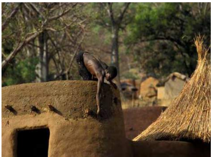
Figura III.9. Reparación de revocos. (Procedencia gráfica: Joffroy, T.).
