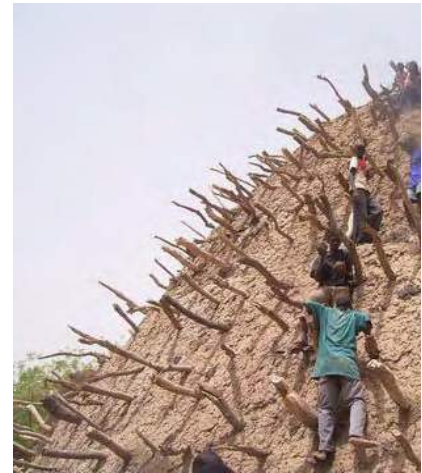
Figura III.2. Trabajos colectivos de reparación de superficies. (Procedencia gráfica: Joffroy, T).
