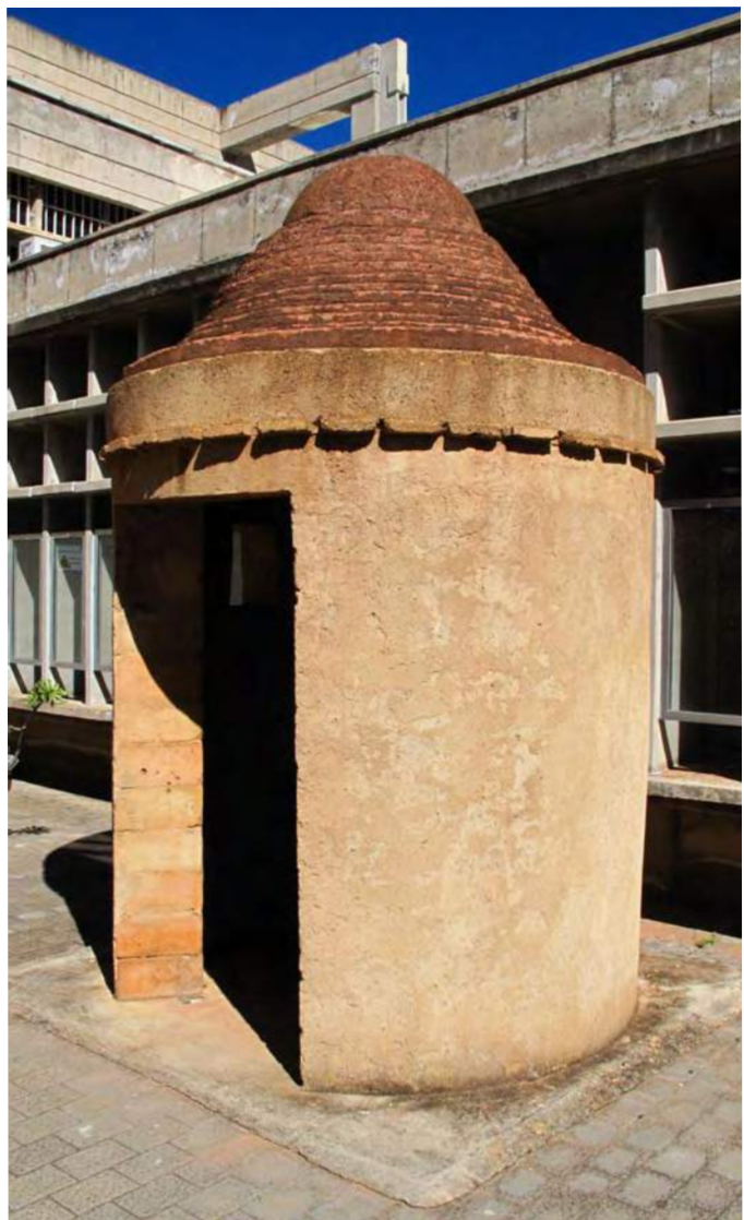
Figura 0.8. Estructura situada en el exterior de la Escuela de Arquitectura de la ULPGC, testigo de la experimentación con tierra cruda llevada a cabo por el Departamento de Construcción Arquitectónica. (Procedencia gráfica: Díaz, I.).
