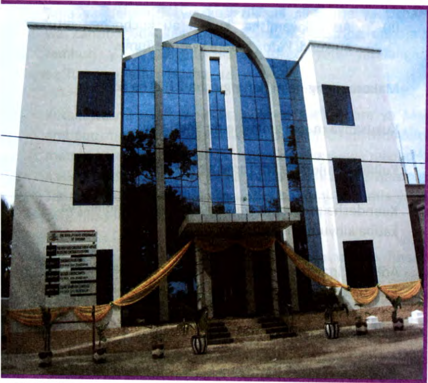
Ofisi Ndogo ya Tume ya Mabadiliko ya Katiba iliyopo katika jengo la Mfuko wa Barabara - Zanzibar.
