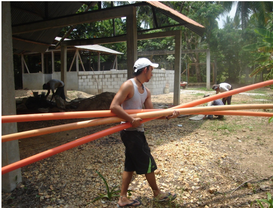
Figura No. 26 A. Instalación del sistema de desfogue de laboratorio.
