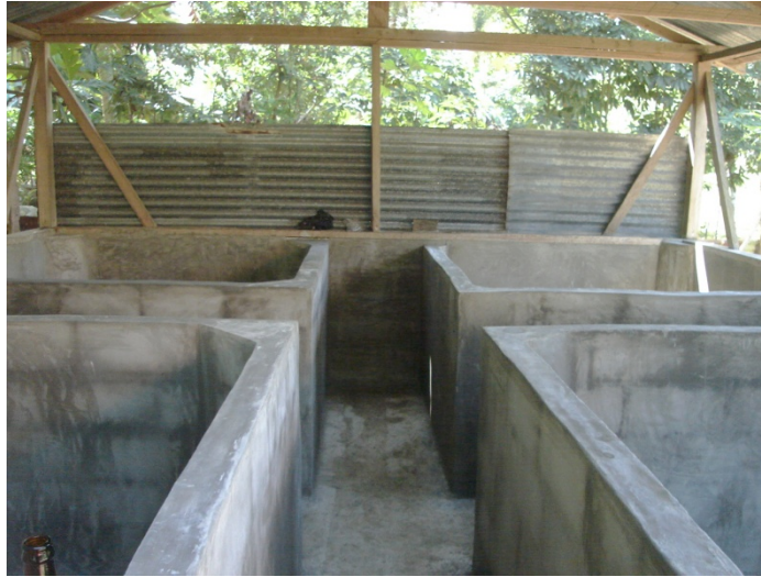
Figura No. 5 Construcción de área de laboratorio experimental.
