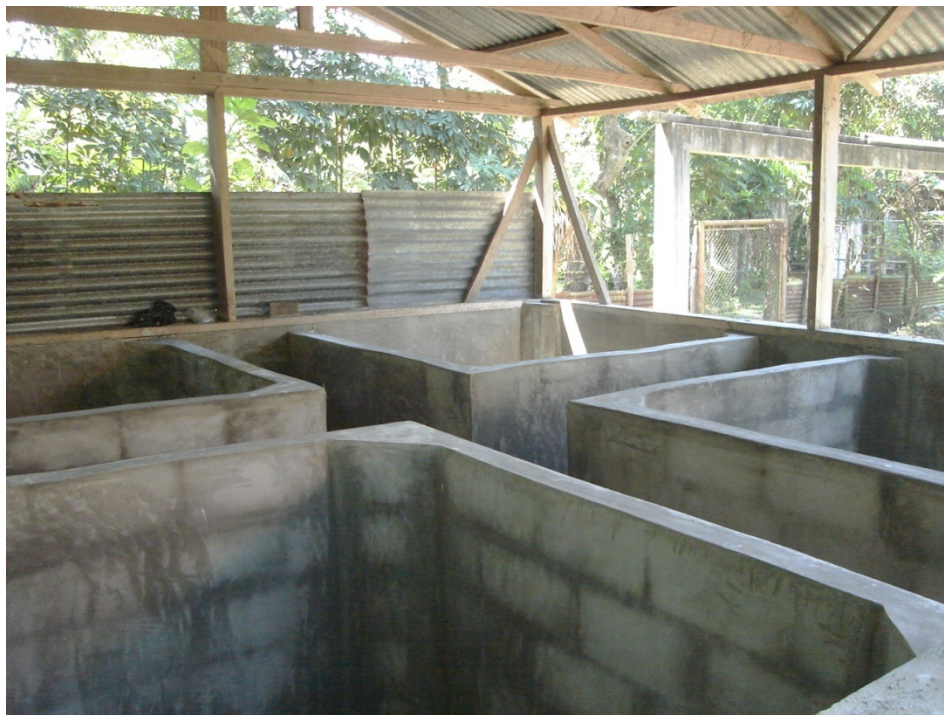
Figura No. 12 A. Construcción de laboratorio de Vieja maculicauda
