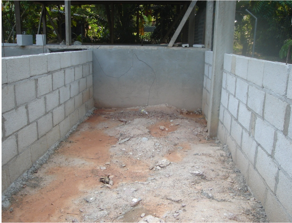
Figura No. 15 A. Unidad de producción en construcción.
