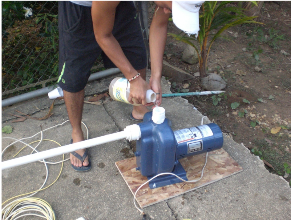
Figura No. 19 A. Instalación de bomba hidráulica.
