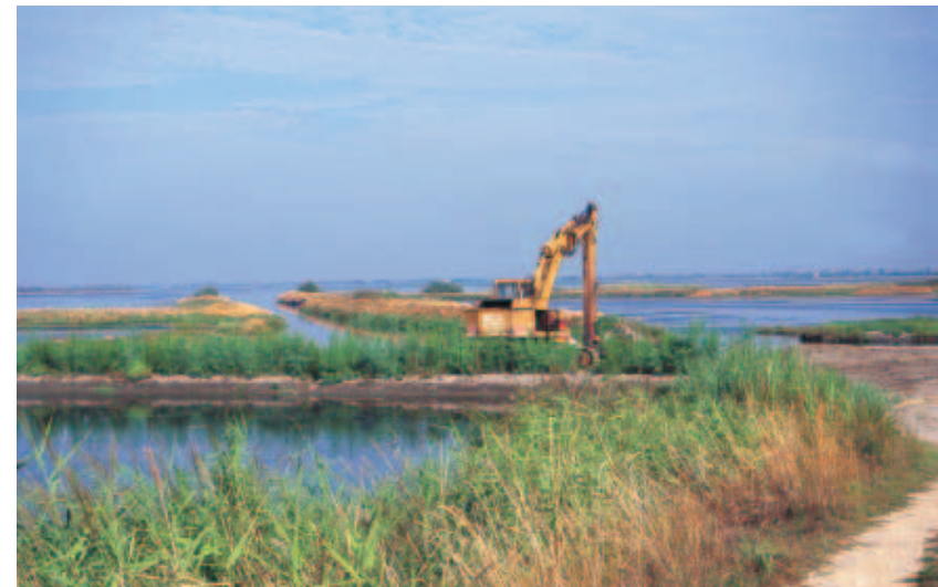
L'escavazione dei sedimenti viene anche svolta per mantenere costante il livello del fondo
