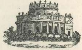
Rotonda sul giardino dei Ripari.
