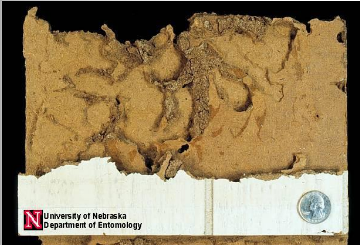
daños en cartón
