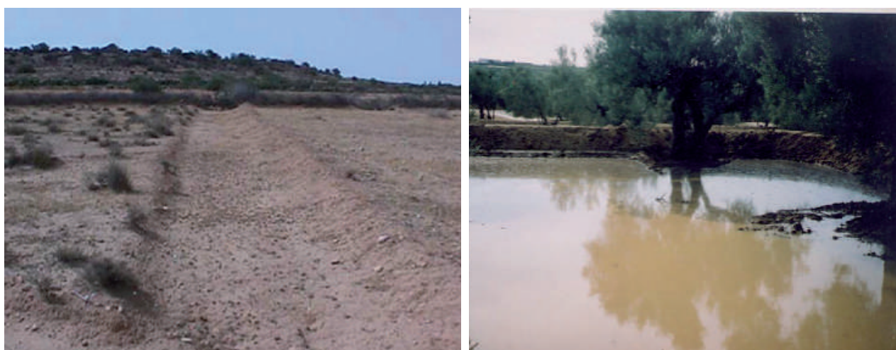
Figure 3.2.12.7. Ejemplo de macrocaptación de agua en una zona olivarera de Túnez, meskats. Zona de aportación (izquierda) y zona de almacenamiento (derecha). (Foto M. Braham).
