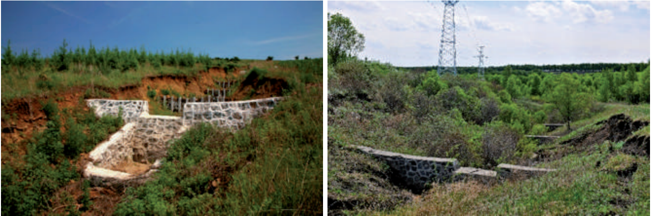
Figura 3.2.8.7. Presas de contención de ladrillo para el control de cárcavas en China (Foto L.Meng).
