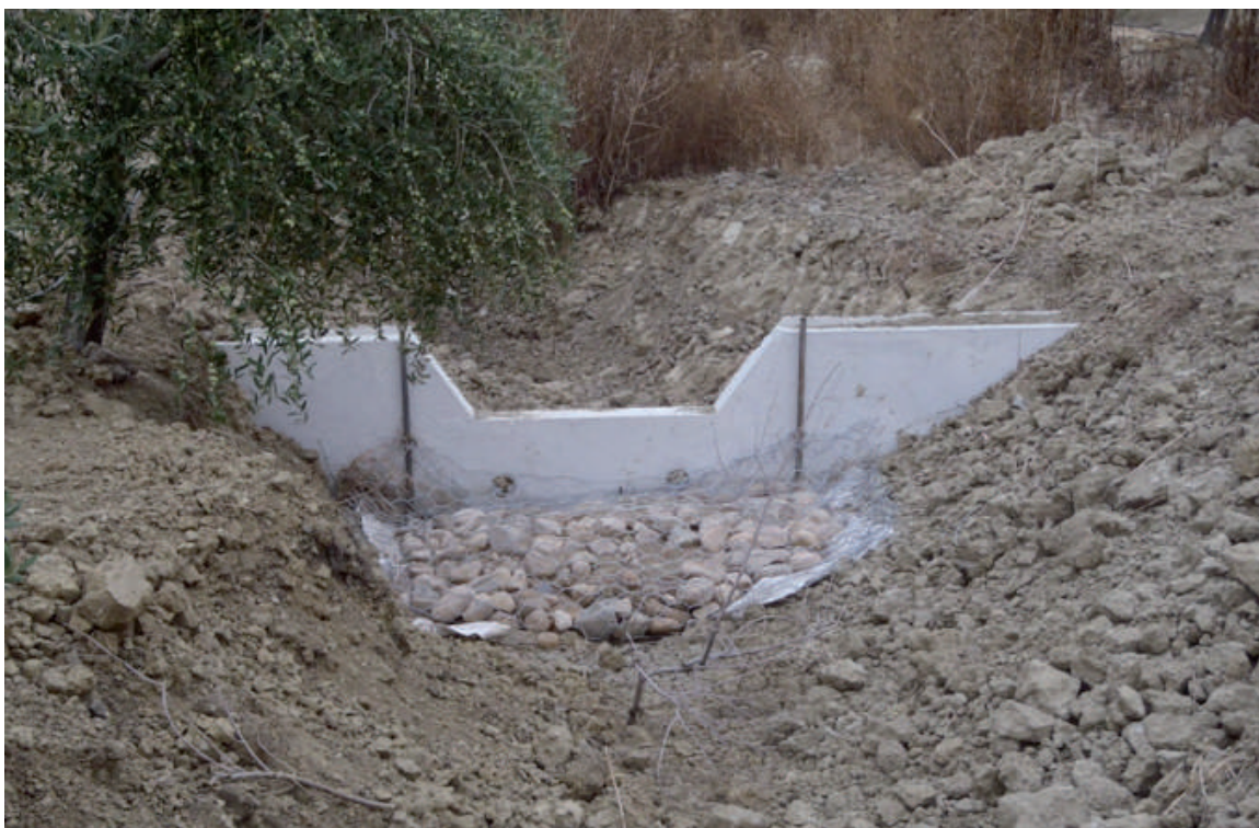
Figura 3.2.8.6. Vista del aliviadero y de la protección de los pies en una pequeña presa de contención (Foto J.A. Gómez).
