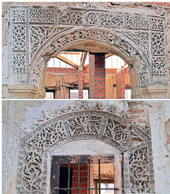
Fig. 11. Yeserías en la planta alta del patio del palacio de la reina, c. 1456 (foto: Cristina Gómez).
