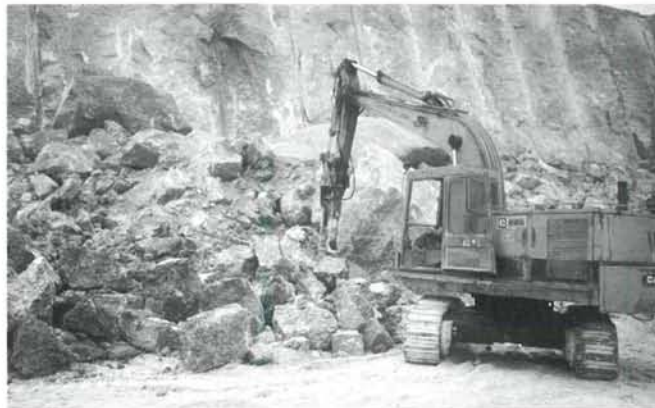
Fig. 9. Fragmentación secundaria con martillo demoledor.
