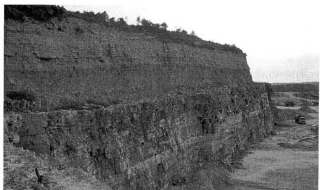
Fig. 3. Cantera «Idysa». Detalle del frente, recubrimiento de estériles; bermas. Jorba. Barcelona.
