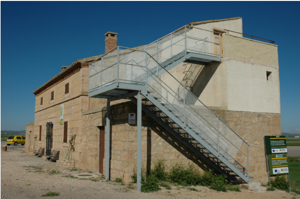
Figura 8. Centro de Interpretación de la Laguna de Gallocanta. - Gallocanta Lake Interpretation Center.
