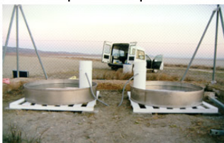
Tanques de tipo A
