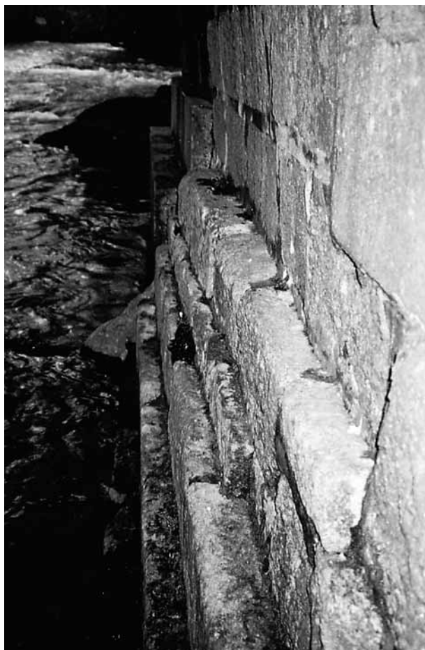
Figura 5: Detalle da base interior dun dos pilares.
