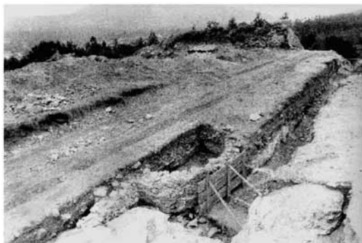
Figura 4: Restos de edificación no castro de Laxos.
