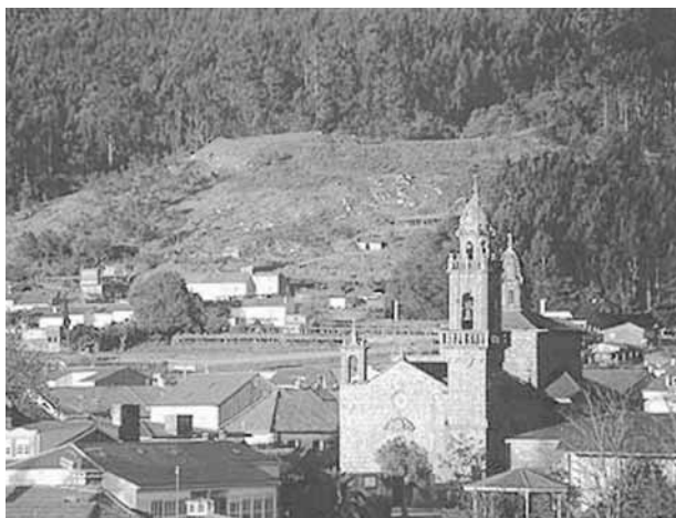
Figura 5: O castro de Castrolandín: monumento construído para ver e ser visto.
