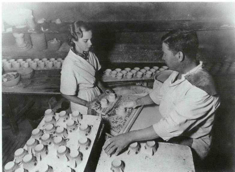
9. Glasering gick under mellankrigstiden fortfarande till som på 1800-talet. Glasering av rågodset sker genom att doppa det i en välling bestående av finmalen kaolin, fältspat, kvarts m fl glasbildande ämnen i vatten. Gustavsberg. Foto STM.
