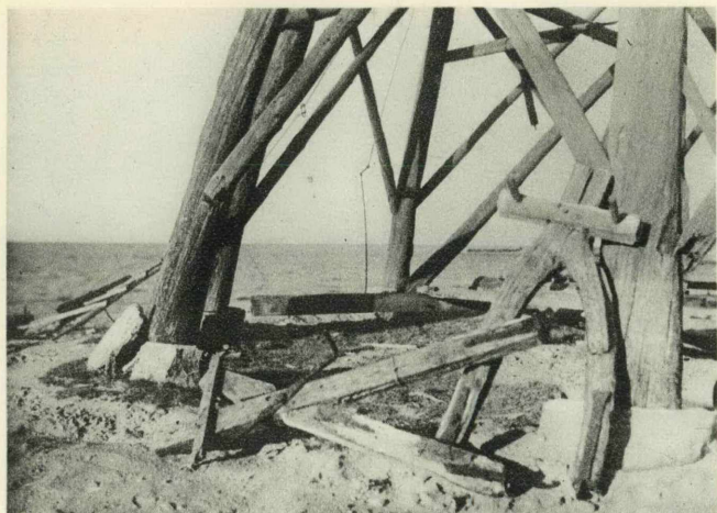
4. »Stenringen» i en skurkvarn med olika typer av »stenfästen» Sandvik.
