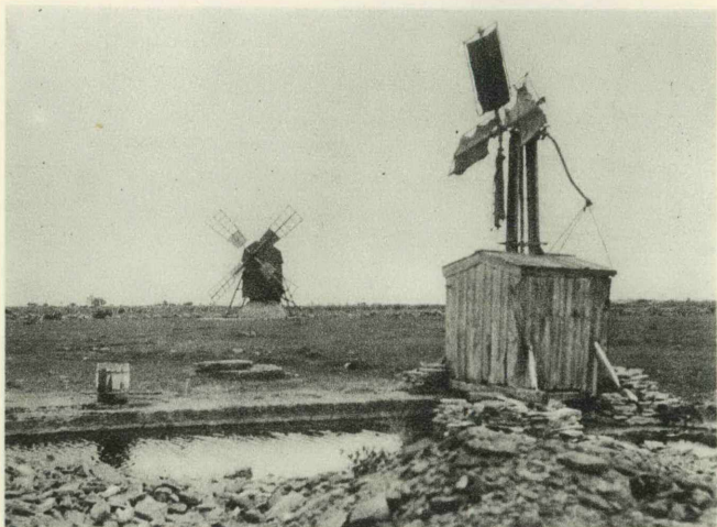
6. Pumpverk i kombination med en holländsk väderkvarn vid Ölands Alunbruk, Degerhamn. I bakgrunden t. v. askbögar, härrörande från alun-tillverkningen.
