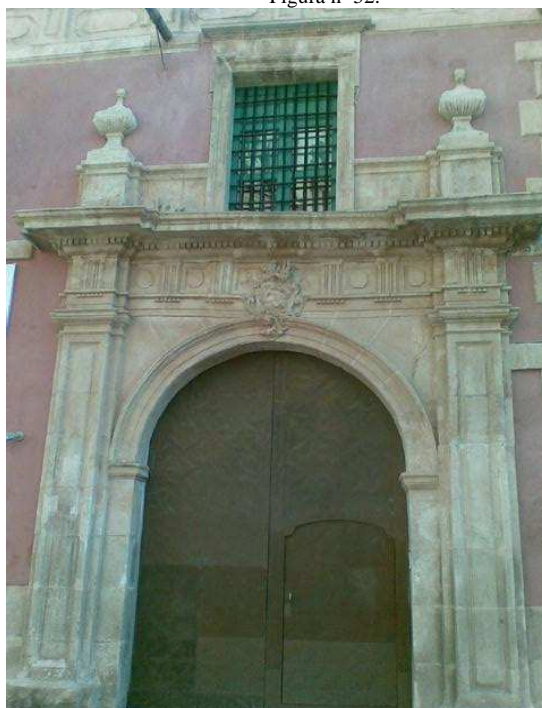
Puerta y fachada de la antigua prisión eclesiástica. Fuente: Archivo privado del autor.
