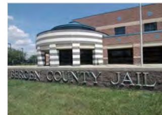
Bergen County Jail 820 MOBOTIX Kameras, USA
