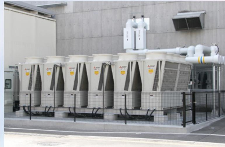
▲第4鑄造工場内の作業員に対する温熱環境改善として採用した空冷式ヒートポンプチラー「DT-RIII」
