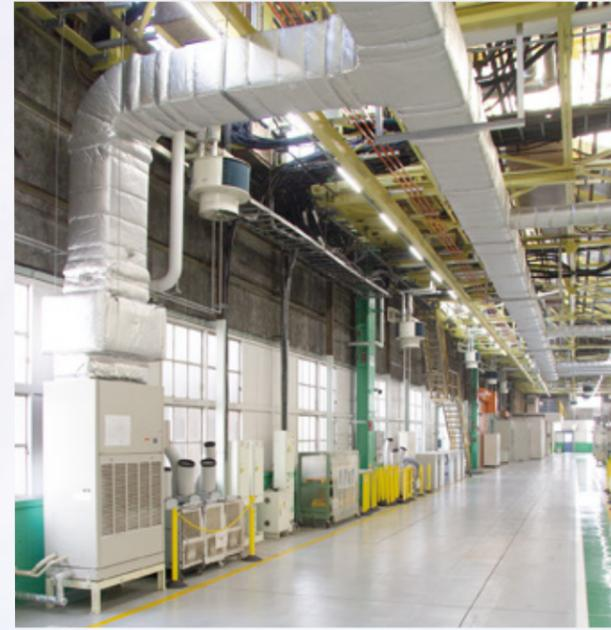
▲第10機械工場生産ラインのダクト空調として採用された、設備用パッケージエアコン「ファシリアDD」
