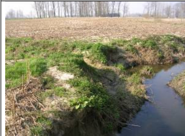
Machineschade aan oevers
