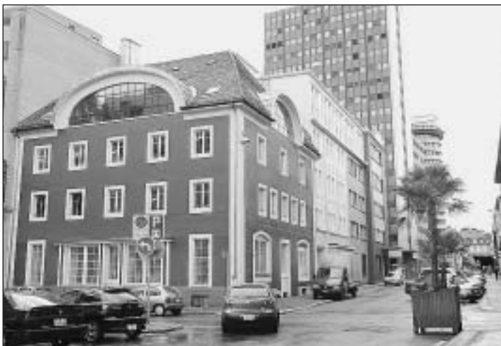
La vieille maison sur la place du Marché et ses annexes, rue du Marché, ont belle allure avec leur variation de tons.
