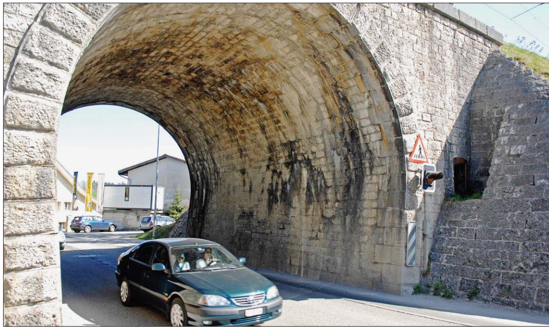
SOUS-VOIE DES CFF Il est trop dangereux pour les enfants habitant aux environs du quartier du Cerisier de rentrer à pied, notamment au passage du sous-voie, où il n'y a pas de véritable trottoir. (DAVID MARCHON)
