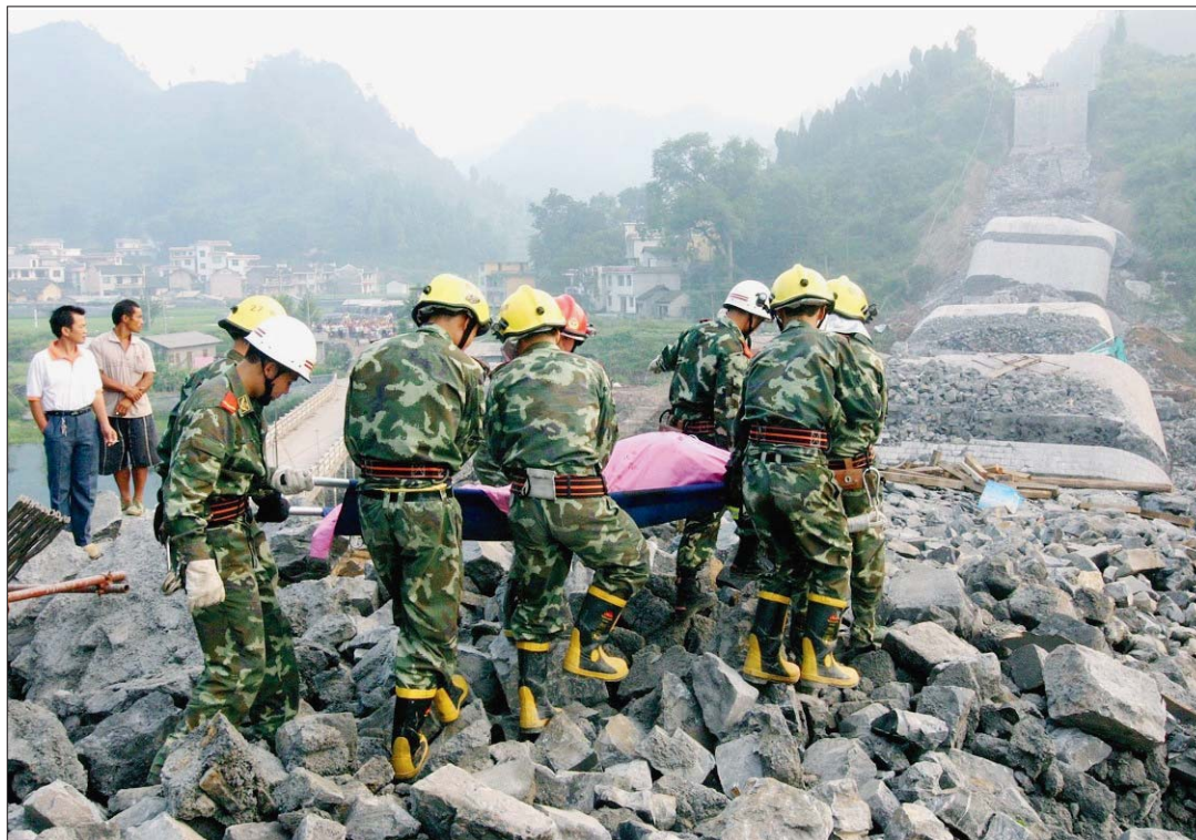
FENGHUANG Des secouristes évacuent le corps d'une victime dans les débris du pont qui s'est effondré. La tragédie a fait au moins une trentaine de morts. (KEYSTONE)
