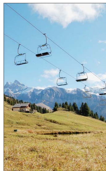
CÂBLES Un télésiège arrêté entre la Croix de Culet et le col de Cou.
