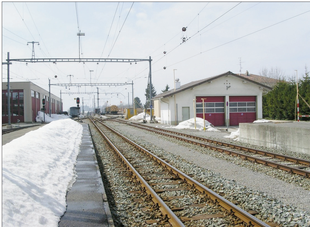
GARE DE SAIGNELÉGIER Derrière le futur nouveau dépôt de bus (à droite), un parking pour les employés sera aménagé, ce qui libérera les places, déjà comptées, devant la gare. (DELPHINE WILLEMEN)
