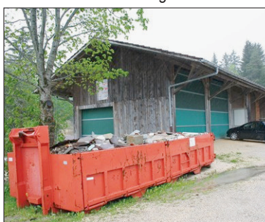
LAJOUX La déchetterie sous toit. (DWI)
