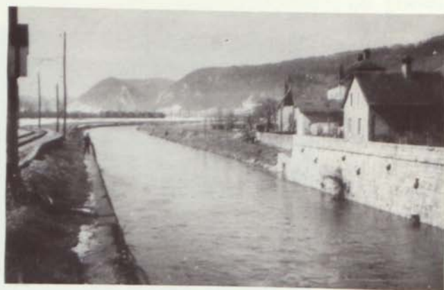
Les travaux terminés. Un beau mur, du beau travail.
