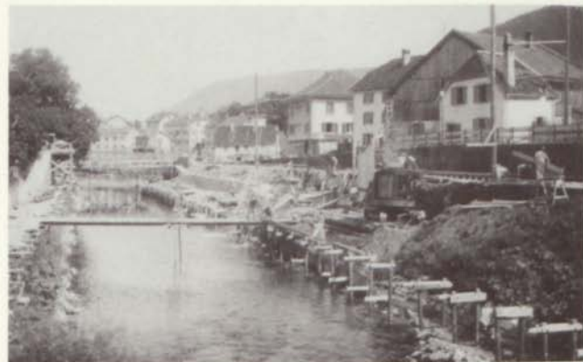
Travaux délicats. Crêt-de-l'Eau.
