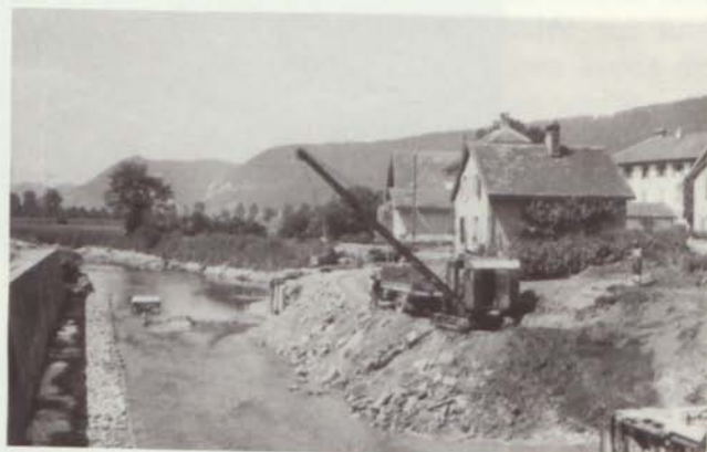
Les travaux, rive gauche.
