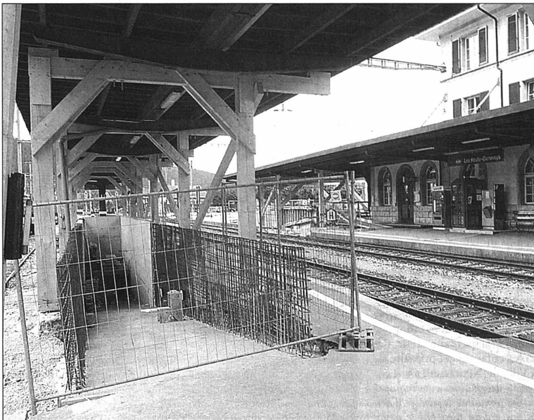
Les travaux du sous-voie de la gare devraient être achevés à fin août. PHOTO LEUENBERGER
