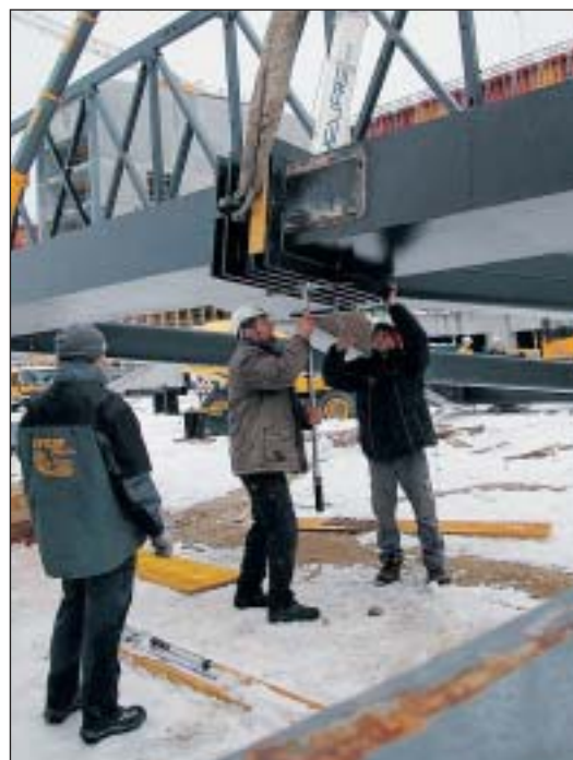
L'assemblage des pièces métalliques a été éprouvé une dernière fois avant le montage.
