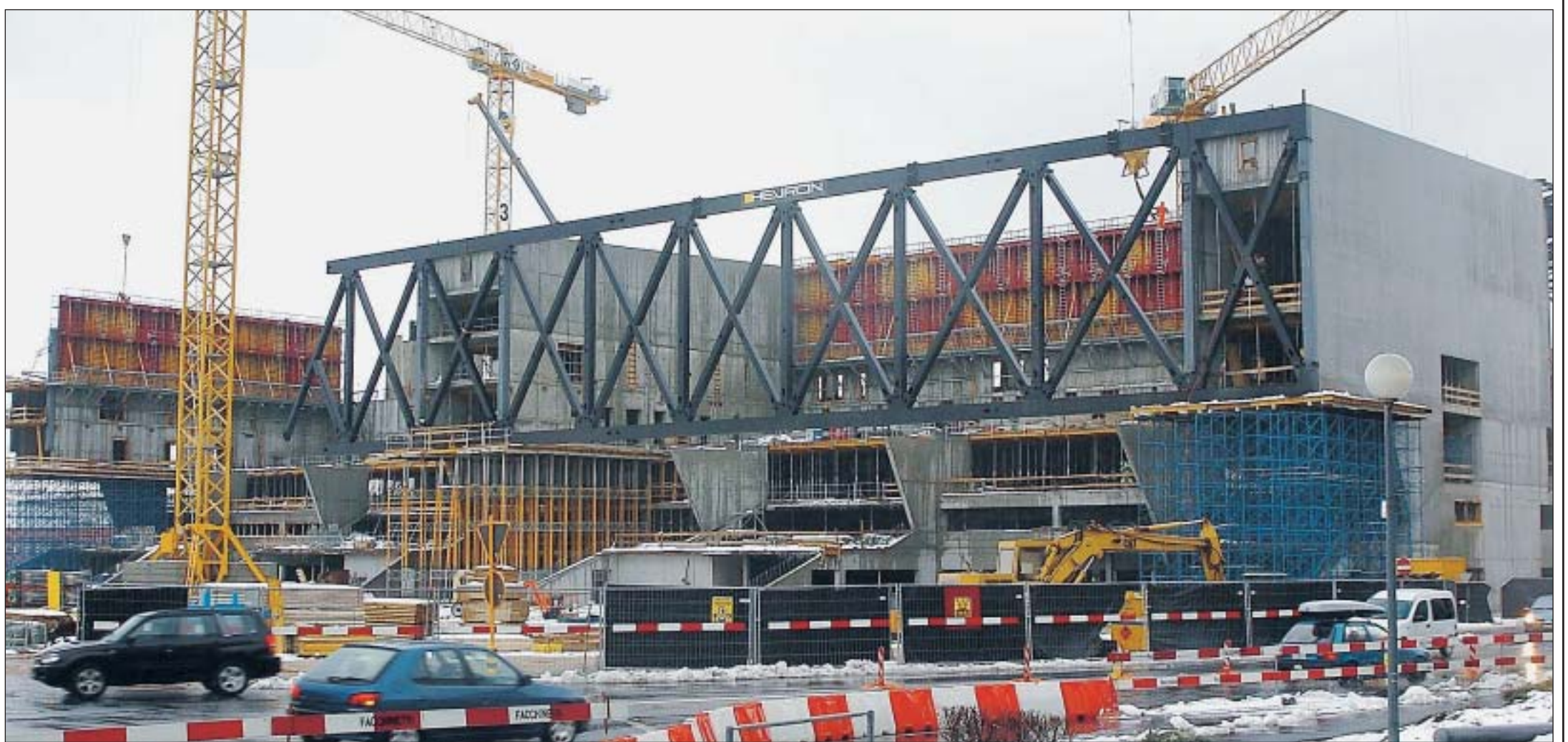
Quatre des cinq éléments de la ferme-treillis sont d'ores et déjà posés. Les salles de gym prendront place entre les piliers en béton.
