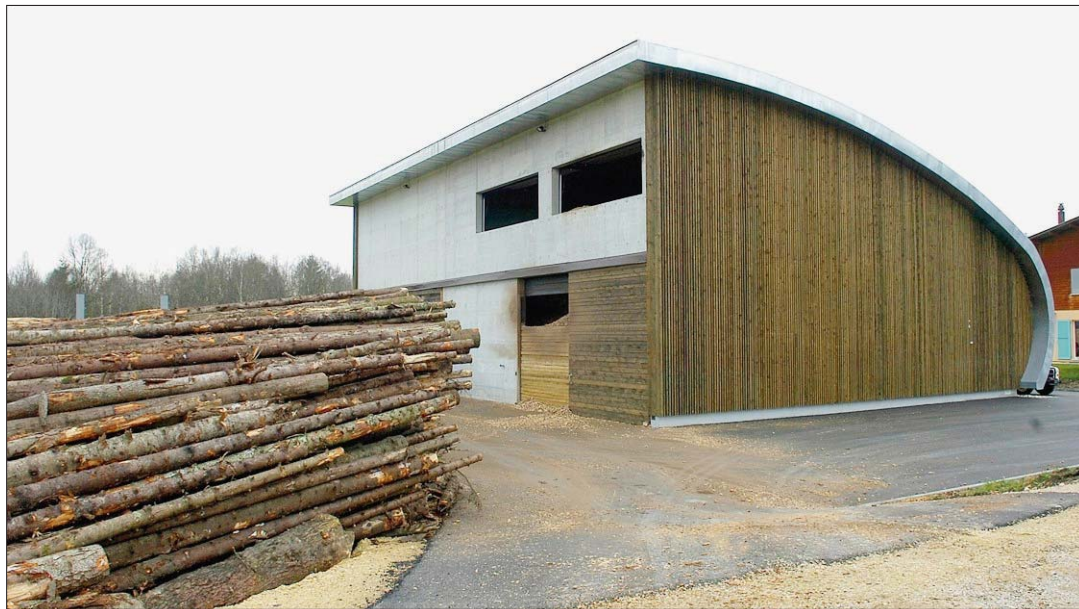
CENTRE FORESTIER Dimanche, la Ville de Neuchâtel inaugurera son nouveau centre forestier des Ponts-de-Martel.
