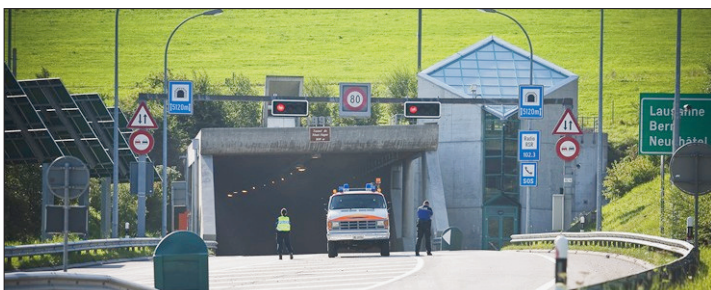
LA VUE-DES-ALPES Le tunnel a été fermé hier matin. (GUILLAUME PERRET)
