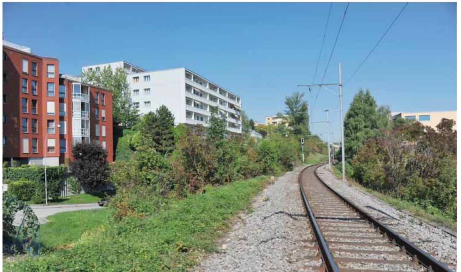
C'est à cet endroit, à la sortie est de Neuchâtel (au sud de la rue des Vignolants), que la nouvelle «gare» de Monruz sera peut-être aménagée.
