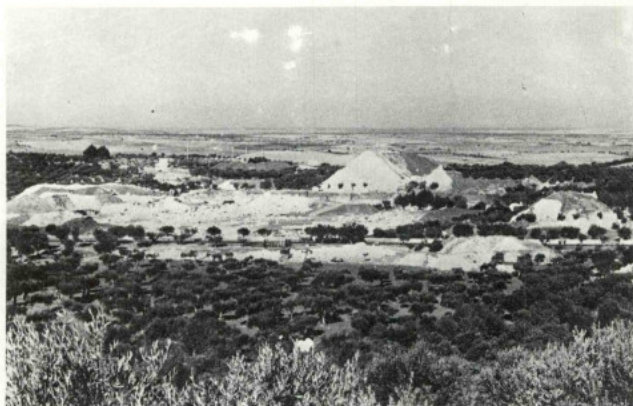
Fig. 1 — Exploração de mármore, entre Borba e Vila Viçosa. Notar a profusão de «poços» de exploração na zona em que a qualidade dos mármore justificava, plenamente, uma frente ampla de ataque. As entulheiras estão dentro da zona de exploração, quando a bem pouca distância, ficam os xistos do Silúrico (zona estéril).
