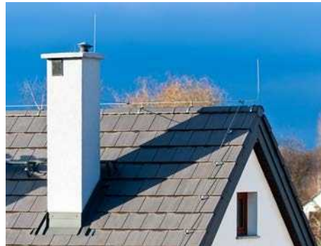
Abb. 15 Äußerer Blitzschutz am Beispiel eines Einfamilienhauses
