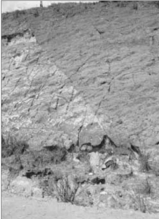
Figura 19: Corte à margem da BR-101, ao norte da cidade de Itabela, sobre a linha divisora das bacias hidrográficas dos rios Buranhém e dos Frades. A descontinuidade oblíqua corresponde à interseção do plano topográfico com o de uma falha inversa, nos sedimentos da formação Barreiras. A direção medida é N60E e o mergulho de 65° para SE. Extraído de Saadi (1996).
